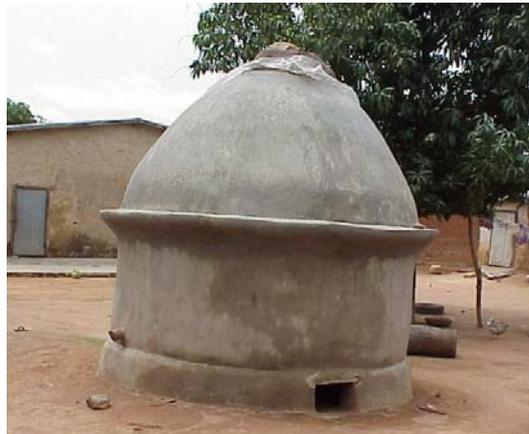
Figure 2 : Enduit ciment sur le corps du grenier [13]
