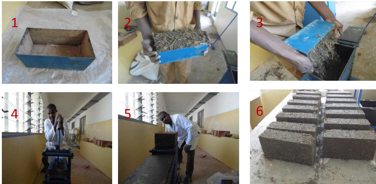
Figure 3-30 : Procédure de préparation des briques en BTC
