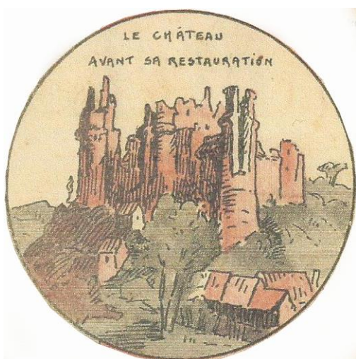
Fig.323. Médaillon : Pierrefonds avant sa restauration.
