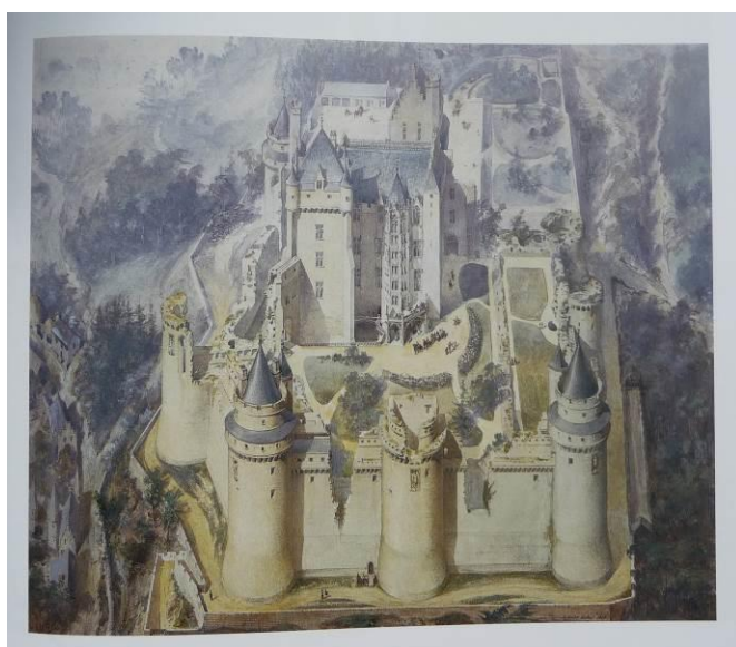
Fig.LIX. Eugène Viollet-le-Duc Vue cavalière du château de Pierrefonds en cours de restauration 1858, aquarelle, Paris, Médiathèque de l'Architecture et du Patrimoine
