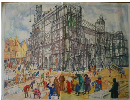
Fig.LX. Scènes actives de construction d'une cathédrale. Planche Rossignol, 1950-1960.
