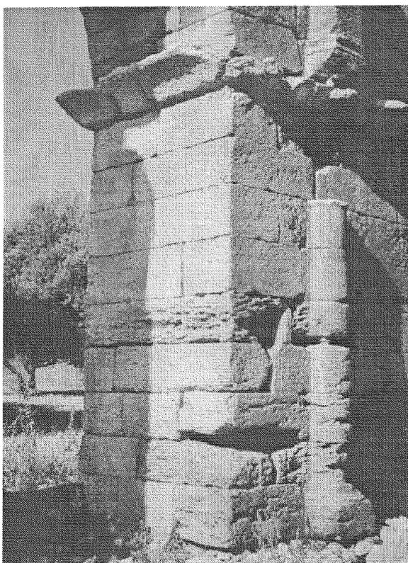
Figure 20 : L'arc d'Althiburos, remarquer son soubassement très réduit et l'imposte.
