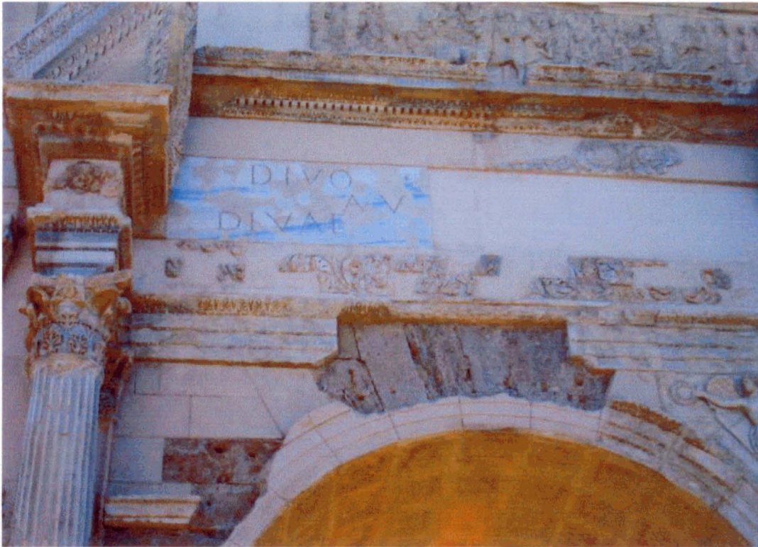
Figure 13 : Autre vue de la façade Est. Sous le revêtement de marbre, les claveaux de la baie
