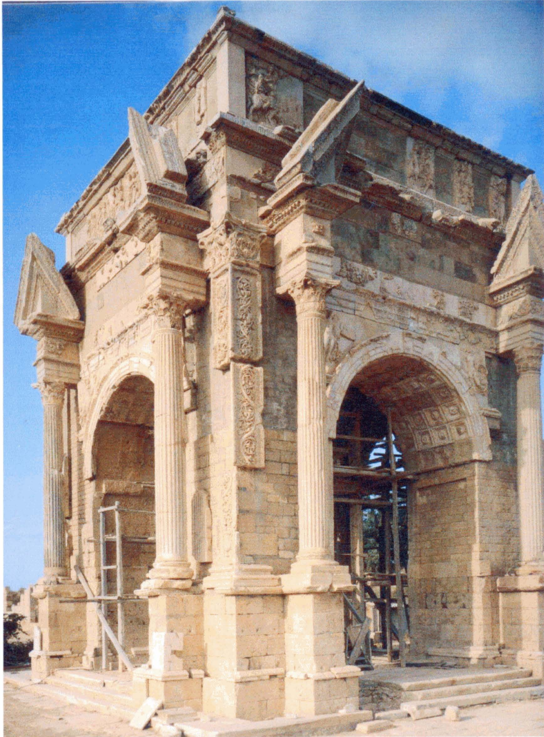
Figure 17 : L'arc vu du Sud, in di Vita 1998, même orientation que la fig. 2006. On peut voir encore très nettement la structure originelle en calcaire, remontée ou complétée. On comprend que les corniches d'impostes sont rapportées, comme les « pilastres d'angle », abstraction faite de leurs bases, prévues dans l'arc d'origine : le trompe-l'oeil et le décor de la mise en scène se mettent en place.
