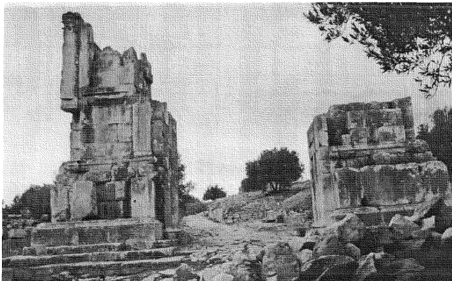
Figure 2: L'arc vu de l'Est.
