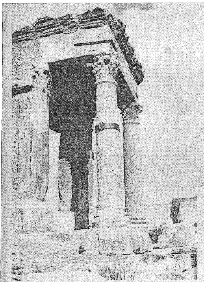
Figure 15 : L'édicule de la façade Sud, in Meunier. On remarquera le traitement très exubérant des acanthes aux nervures contournées sur le chapiteau. On devine aussi la feuillure creusée dans le piédroit, destinée à accueillir la balustrade.
