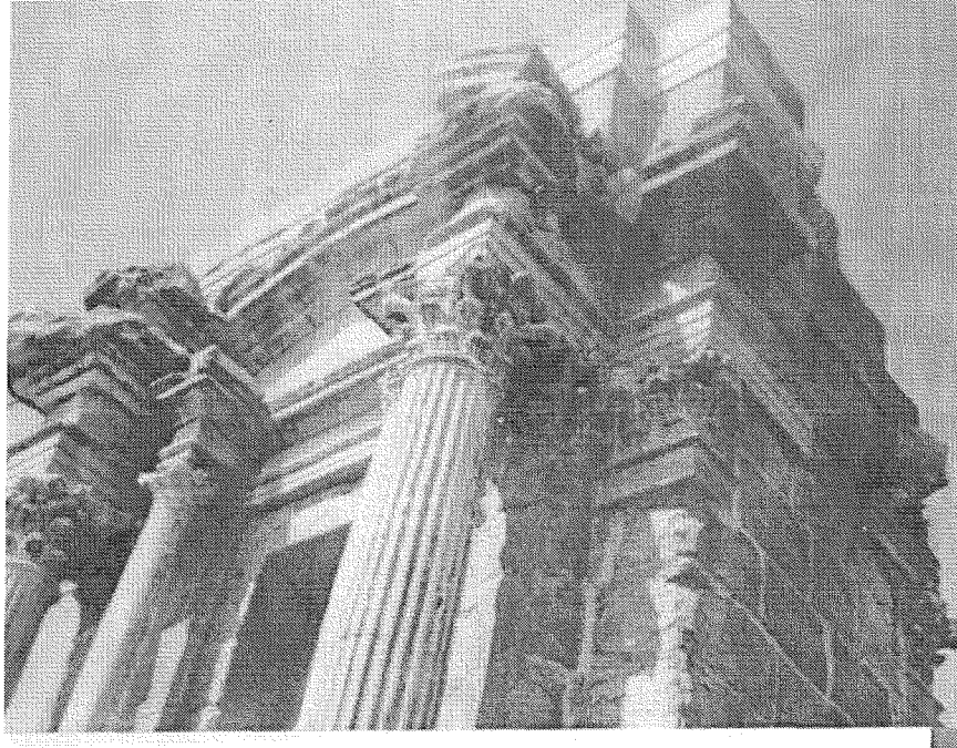
Figure 19: Détail de la face latérale Nord.
