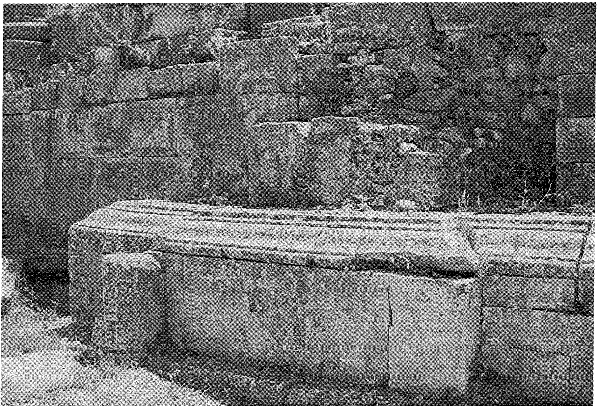
Figure 4 : Le nucleus commun et les moulures du stylobate
