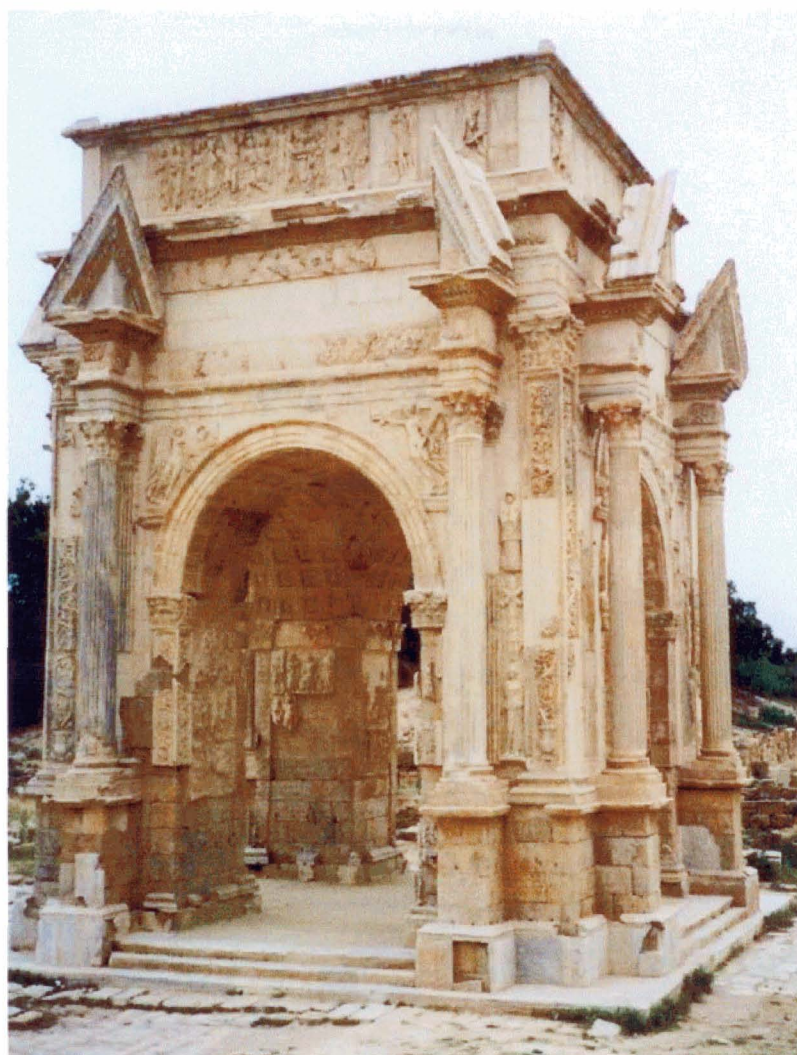
Figure 3: L'arc vu depuis le S-E, 2006. Revêtements et panneaux en place.
