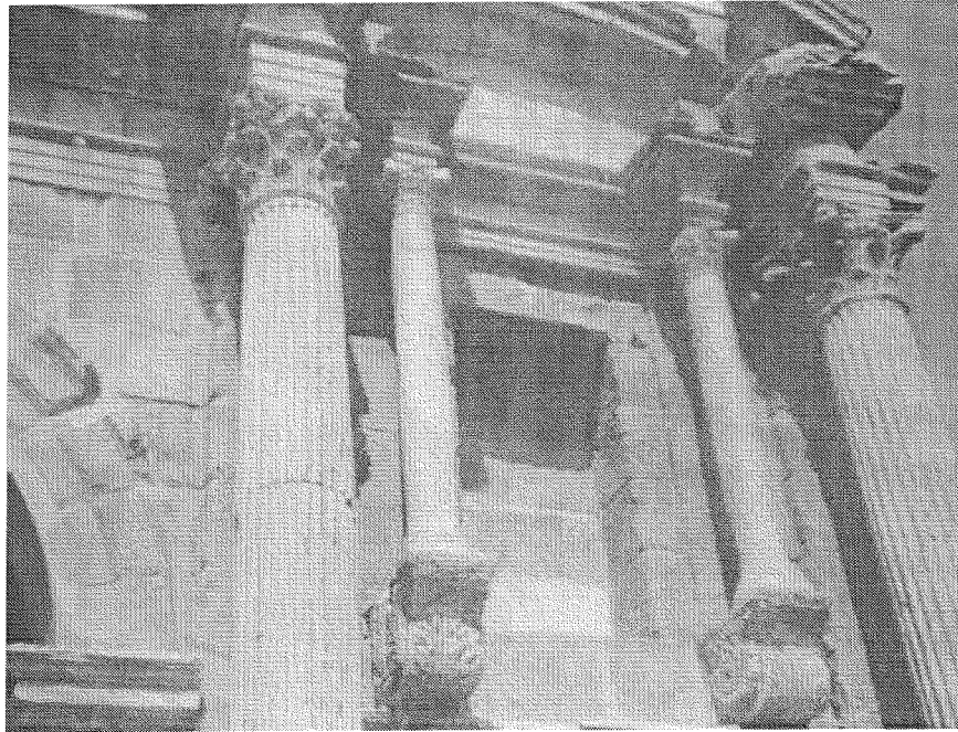
Figure 15: La niche du côté Nord, façade Est, la seule conservée avec ses colonnettes.
