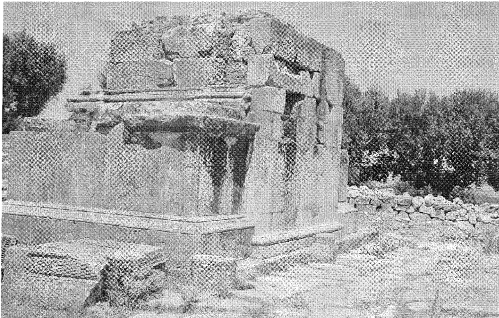
Figure 5: Le piédroit Nord vu de l'Ouest
