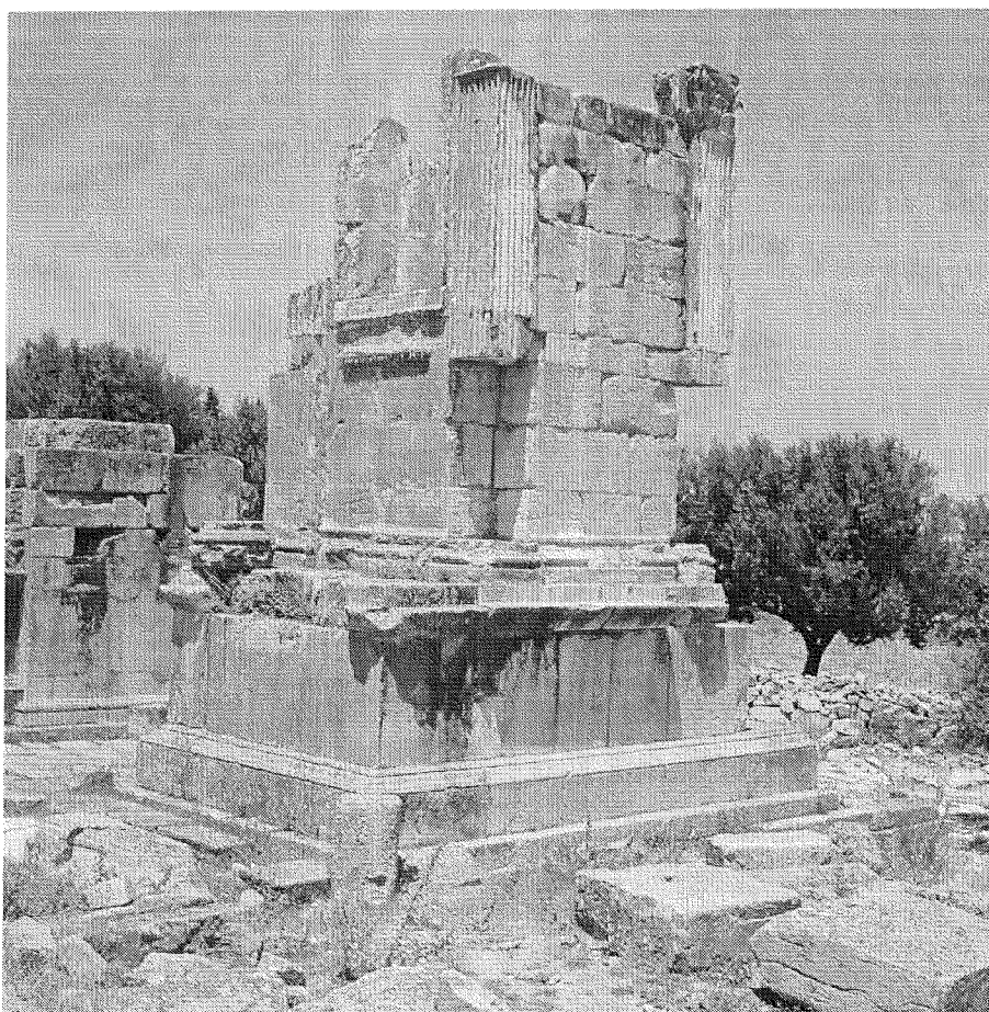
Figure 7: La plinthe continue sur la face extérieure du piédroit Sud, vue du Sud-Ouest.
