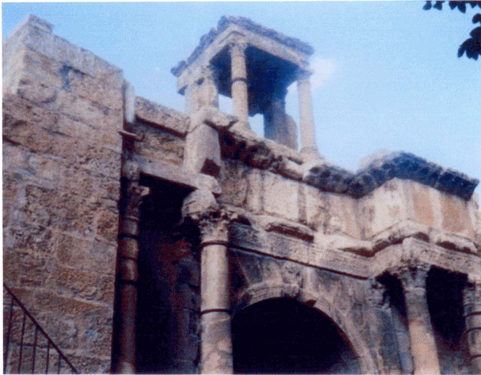
Figure 16: L'édicule de la façade Sud, vue d'ensemble.
