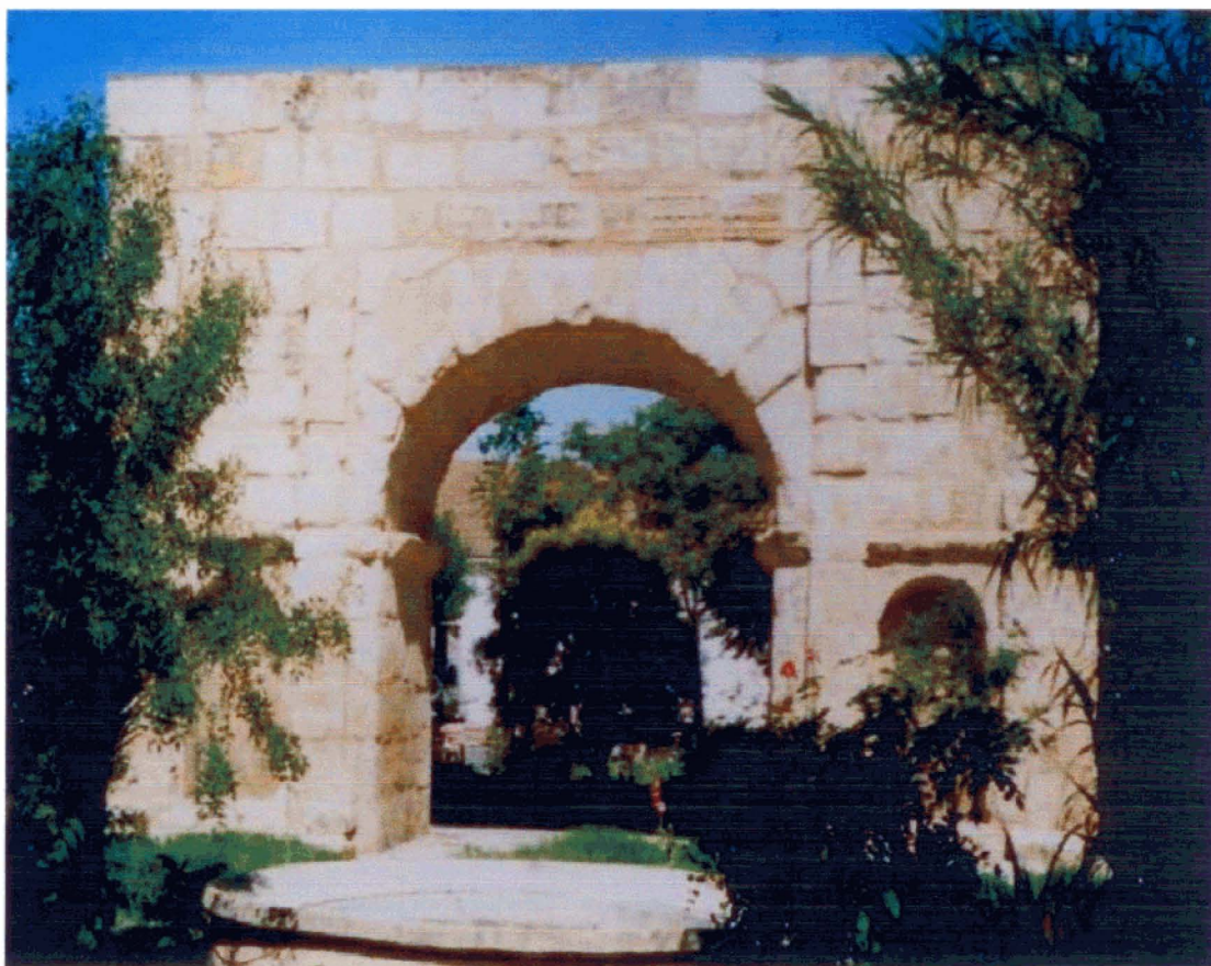
Figure 2 : L'arc de Bab el Aïn en 2005, façade Est.
