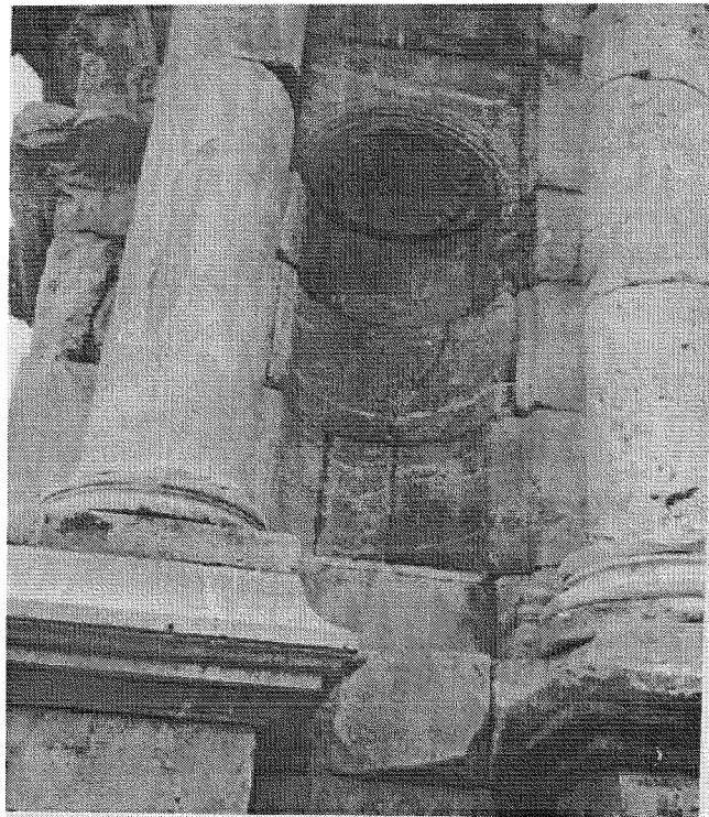
Figure 18: Niche du piédroit Nord, façade Est.
