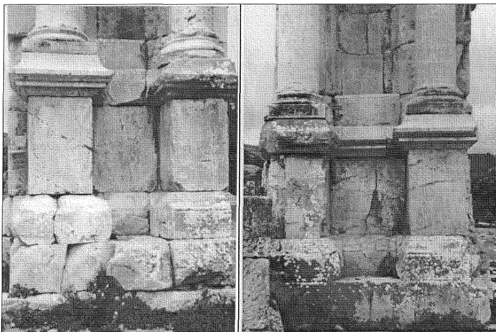
Figure 16: Piédestaux du piédroit Nord, à gauche, et du piédroit Sud, à droite. Remarquer la restauration exemplaire des parties endommagées.
