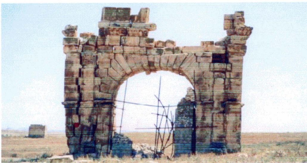
Figure 2: L'arc d'Assuras en 2005.
