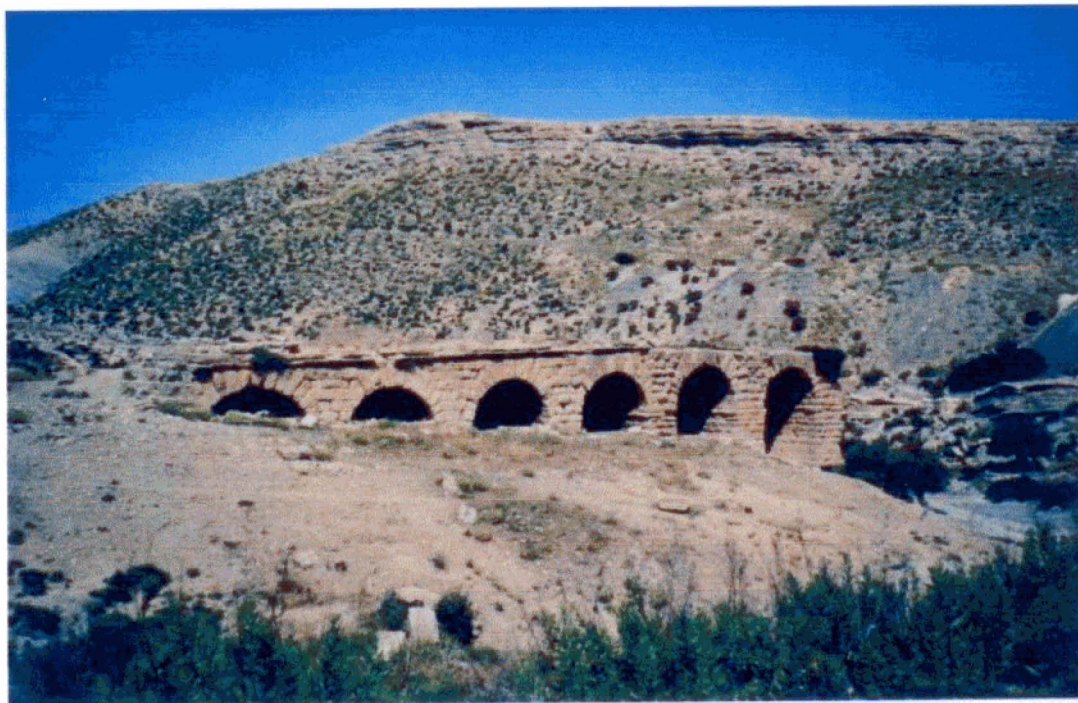
Figure 3 : Pont romain sur l'Oued Djelf : six des dix arches qui le constituaient sont encore visibles.
