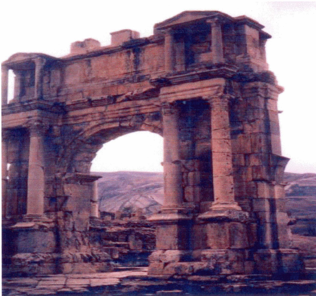
Figure 13: Détail du piédroit Nord, vu de l'Est.
