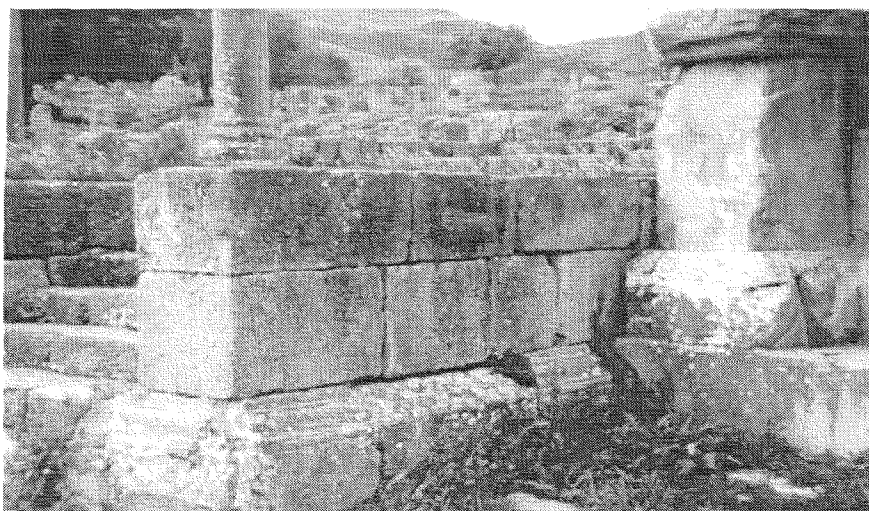
Figure 15: Façade Est, la jonction piédroit Sud-petit temple.
