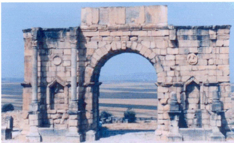
Figure 1 : Arc de Volubilis, façade Est.
