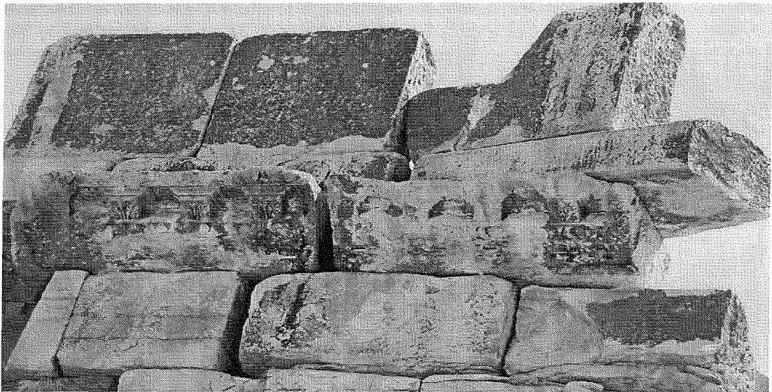
Figure 18: : Modillons de la corniche d'entablement. Trois blocs de la frise d'attique reposent sur des blocs qui n'appartiennent certainement pas à la plinthe d'origine ; ils portent une partie de la dédicace.
