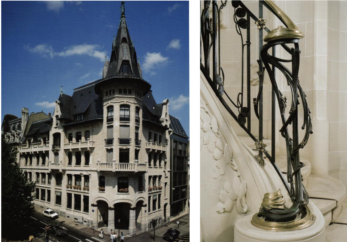
Images 38 : la Banque Nationale de Paris à Nancy, vue extérieure et détails d'une rampe d'escalier à motifs de monnaie du pape.
