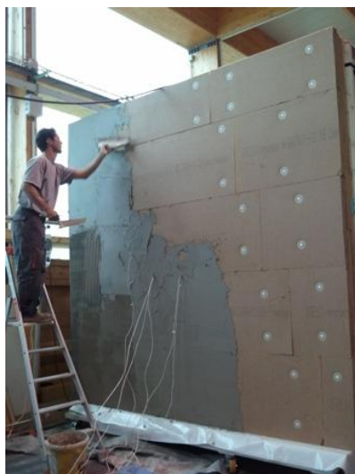
Figure 21. Montage et instrumentation des parois-test
