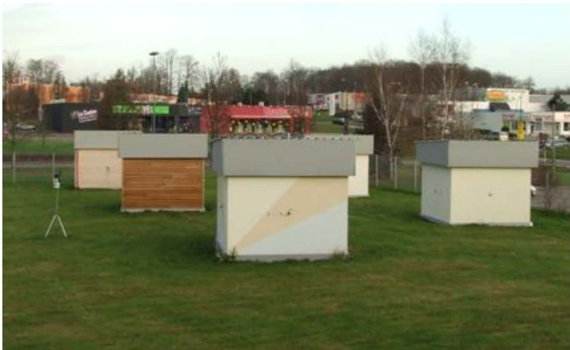
Figure 47. Construction et vue d'ensemble des modules
