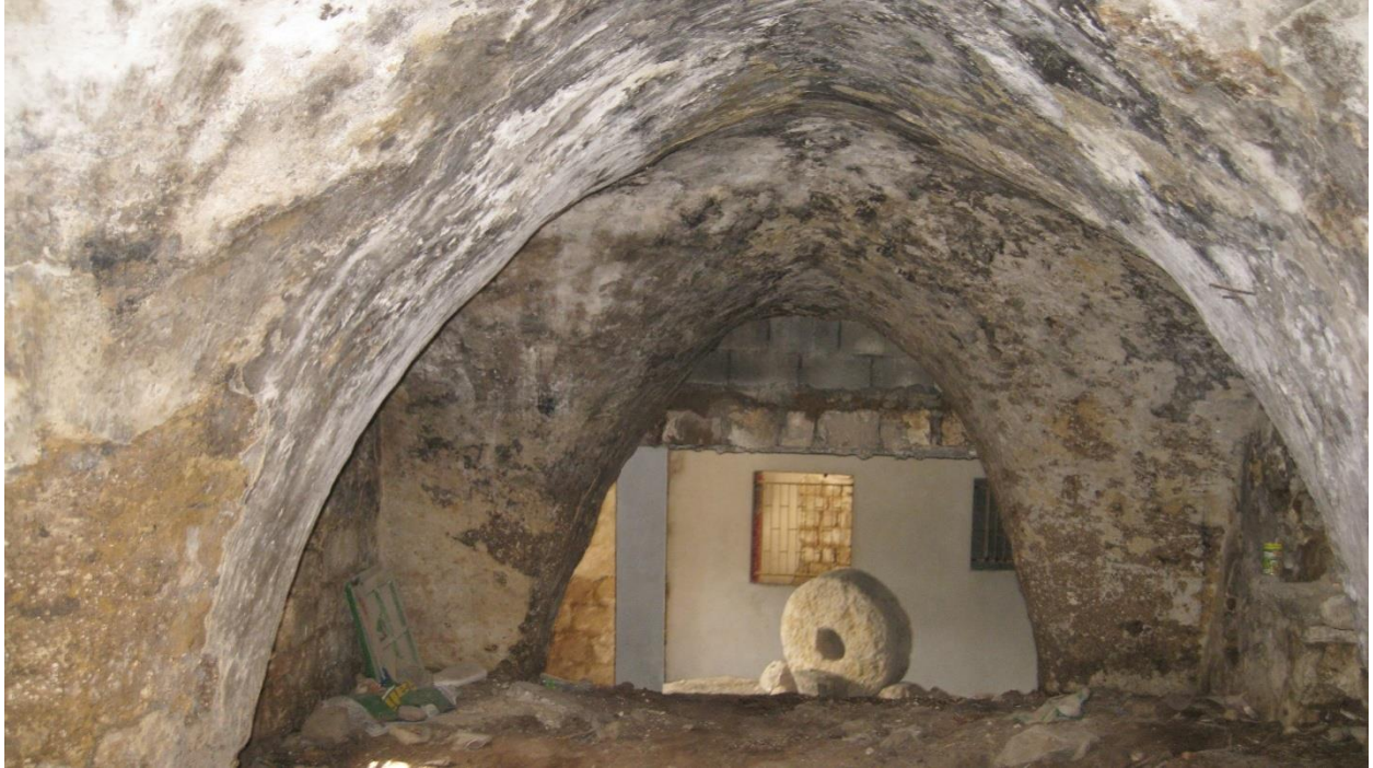
BÂTIMENT 12 - FIGURE 8 BROYEUR DE L'ANCIENNE HUILLERIE, AL-BADD AL-QADIM
