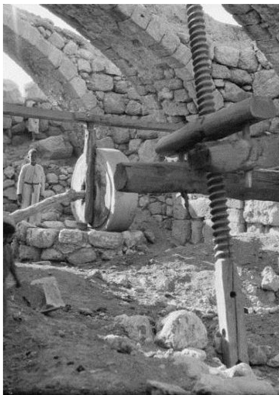
FIGURE 22 VIS EN BOIS MATSON (G. ERIC AND EDITH). COLLECTION DES PHOTOGRAPHES. BEIT-JIBRIN (1920-1933). [PHOTO 488 ].
