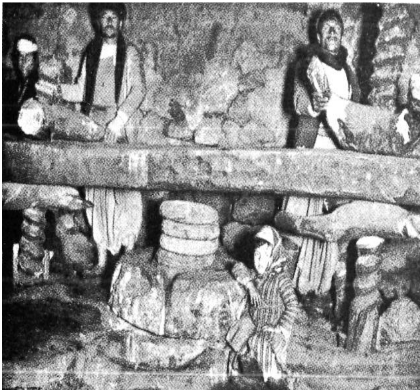
FIGURE 26 PRESSOIR À DOUBLE VIS À PRESSION DIRECTE, PHOTO PRISE PAR DALMAN À BALLAT AU NORD DE LA GALILÉE EN 1900
