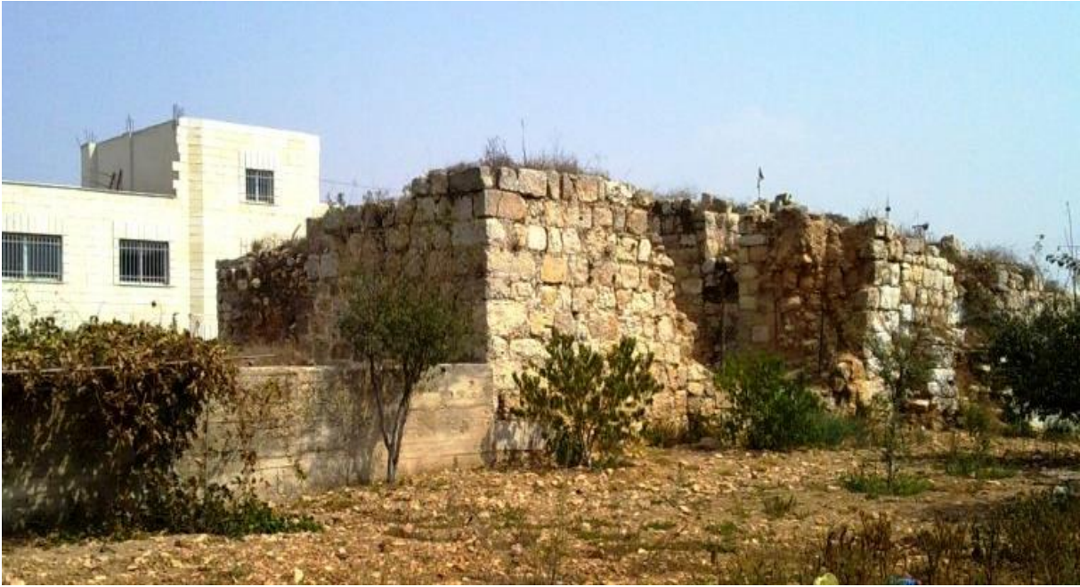
FIGURE 5 VILLAGE N° 24. BETOUNYA (2010). L'ANCIENNE HUILERIE
