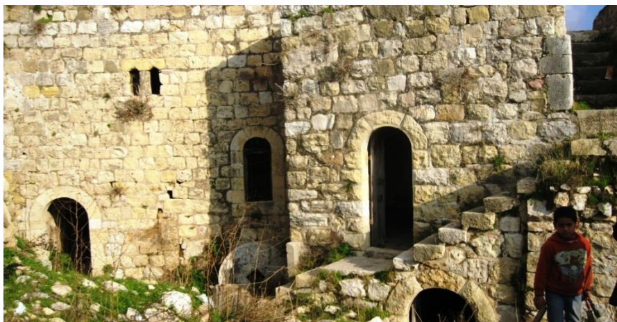
BÂTIMENT 3 - FIGURE 1 HOCH DAR SAMI DĪB MAKHALFEH MEULE À L'EXTÉRIEUR DE L'HUILERIE
