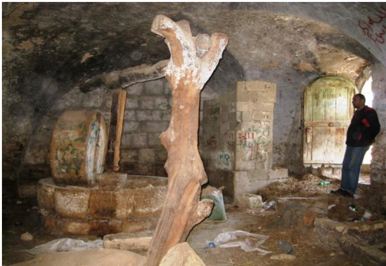
BÂTIMENT 9 - FIGURE 1 INTÉRIEUR DE L'HUILRIE DE DURA EL-QARE' POUTRE SUPÉRIEURE HORIZONTALE DU BROYEUR AL-'ABARA
