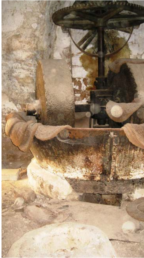
FIGURE 13 VILLAGE N° 42. DEIR GHASSANEH L'ANCIENNE HUILERIE MÉCANIQUE LOBIN & DRUGE D'AIX EN PROVENCE INSTALLATION DE BROYAGE
