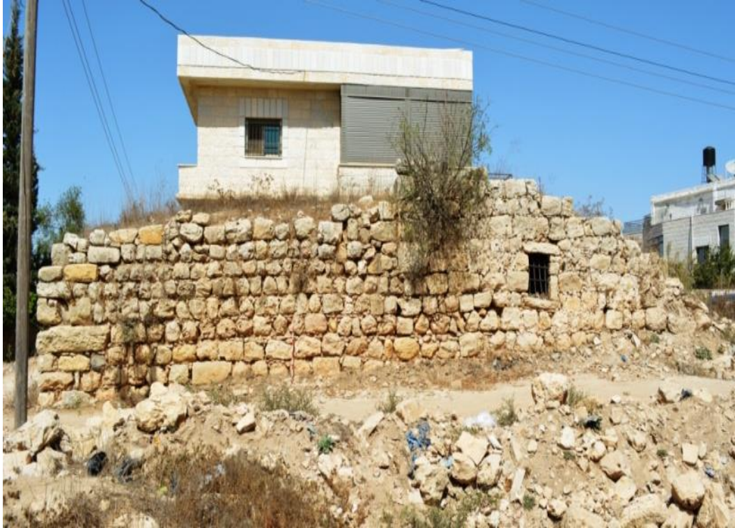
BÂTIMENT 1 - FIGURE 2 VUE LATÉRALE DU BÂTIMENT
