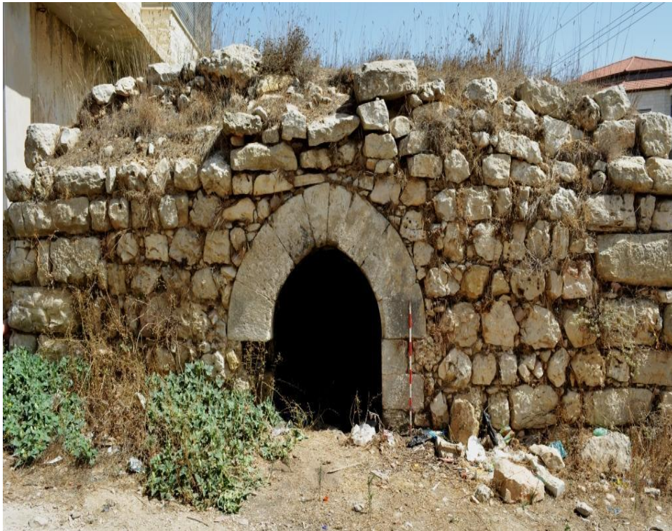
BÂTIMENT 1 - FIGURE 1 INSCRIPTION ET ENTRÉE DU BÂTIMENT À PRESSOIR
