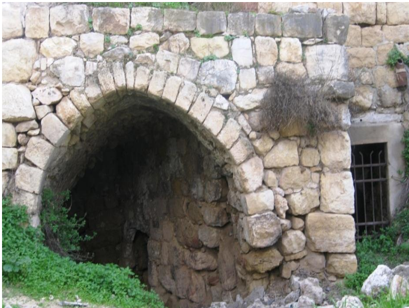
BÂTIMENT 4 - FIGURE 1 ENTRÉE DU BADD EL BAYK OU BADD HUSSEINI
