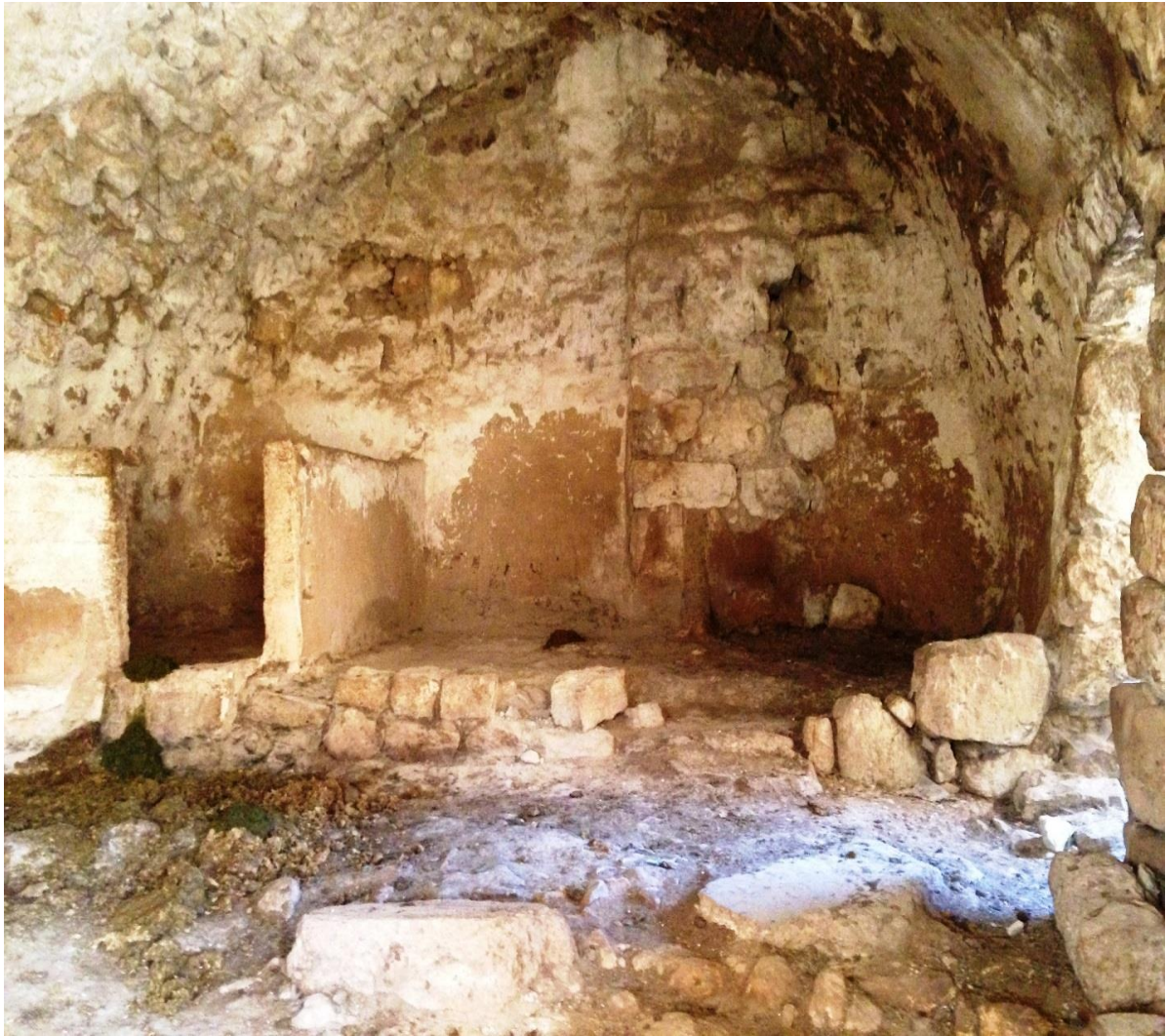
BÂTIMENT 2 - FIGURE 1 INTÉRIEUR DU BADD DAR 'ABDALLAH, EMPLACEMENT DU BROYEUR 1 ET DES MAṢABĀT
