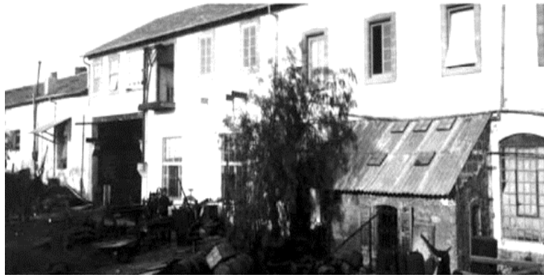
FIGURE 22 L' USINE DES FRÈRES WAGNER A WALHALLA (NON DATÉ) [PHOTO] 1144 .
