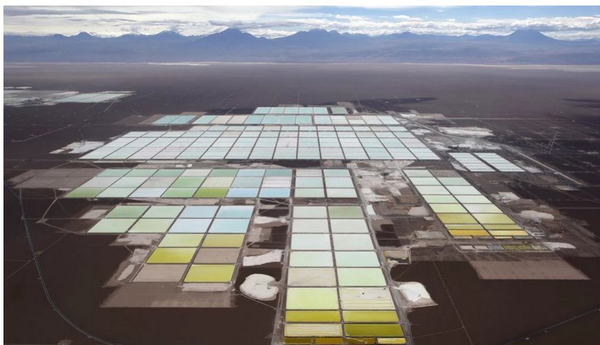
FIGURE 1.17 – Bassins de décantation chiliens qui permettent la séparation de la potasse et du lithium
