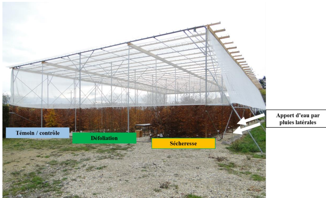
Figure IX.2. Photographie de l'expérimentation mettant en évidence les différents traitements et schématisation de l'entrée d'eau latérale (Crédit photo : C.Massonnet).
