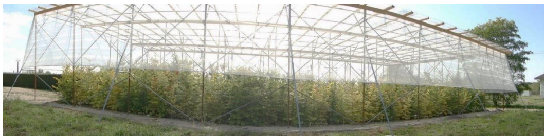
Figure IV.4. Etapes de l'installation du système d'exclusion de pluie. Crédits photos : C. Massonnet et P.A Chuste.
