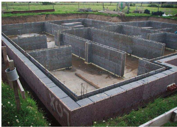
Figure 2.1. Panneaux composites bois-ciment dans les coffrages.
