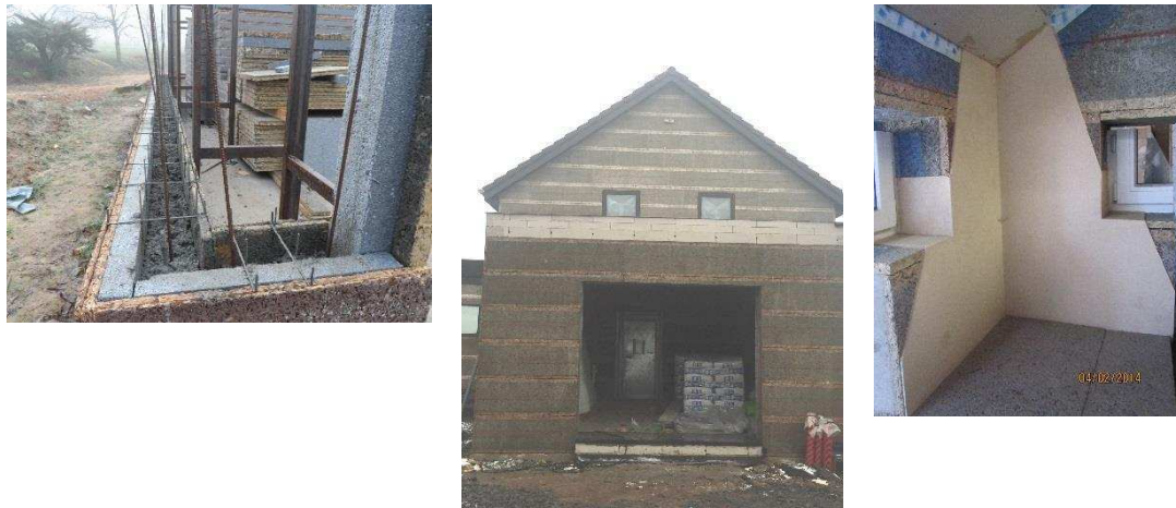
Figure 1.7. Mise en place des panneaux de coffrage bois-ciment.
