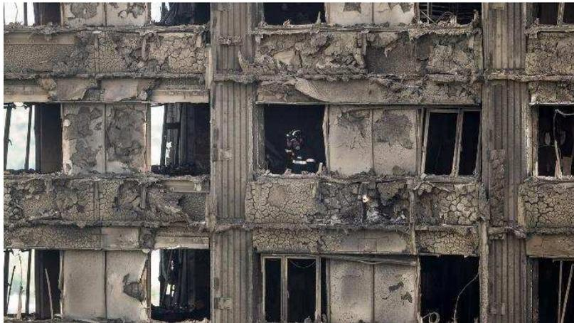
**Figure 4.1.** Dégâts causés sur la façade de la tour Grenfell à Londres par l'incendie.
