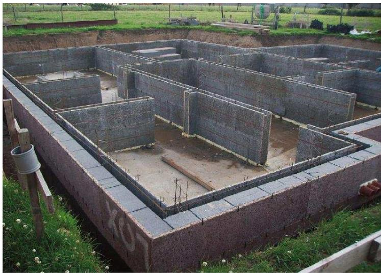
**Figure 2.1.** Panneaux composites bois-ciment dans les coffrages.
