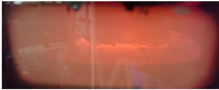
Figure 93 : Photographie du regard de sortie de chambre de combustion lorsque la température atteinte est supérieure à 1050°C.
