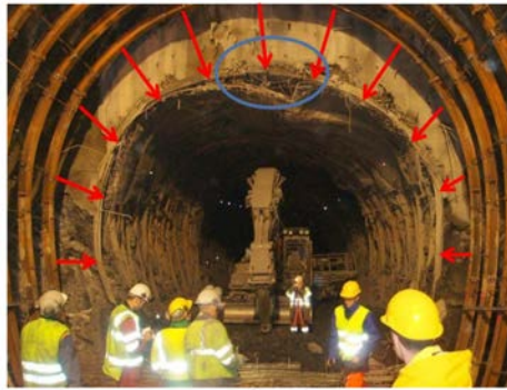
FIGURE 1.11 – Anisotropie de la convergence dans la descenderie de Saint-Martin la Porte - [Manh, 2014].
