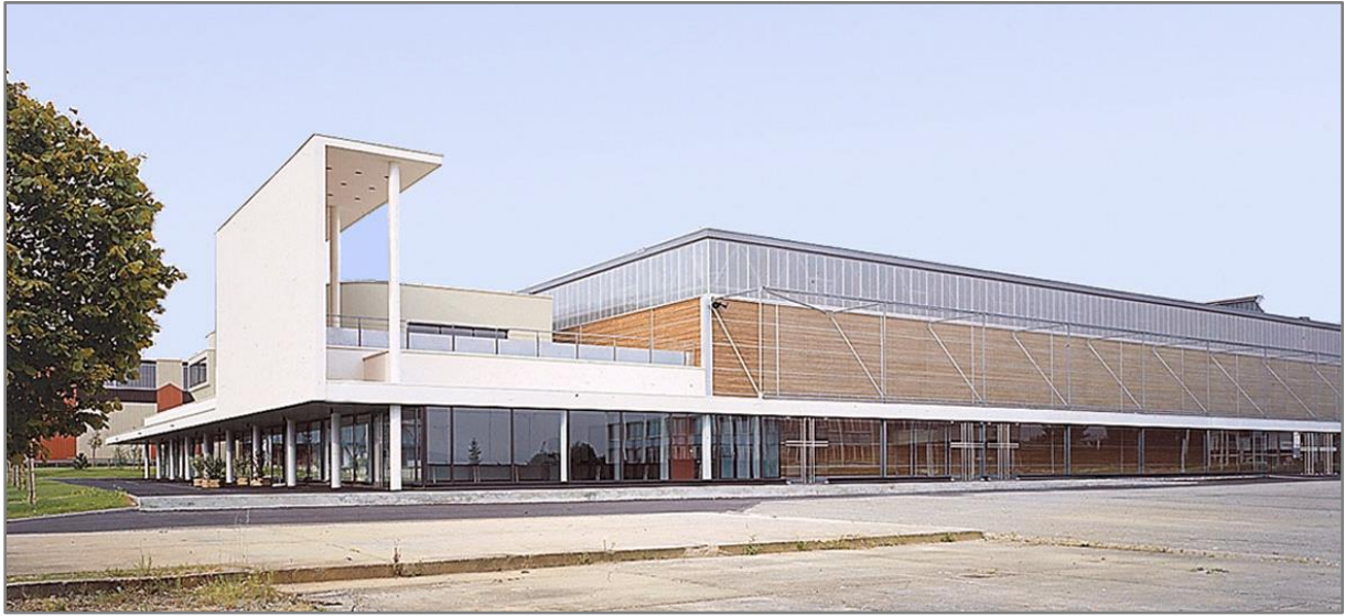
Photographie 78 : L'extension du Hall 1 en 1995 (cliché agence L. Beaudoin)
