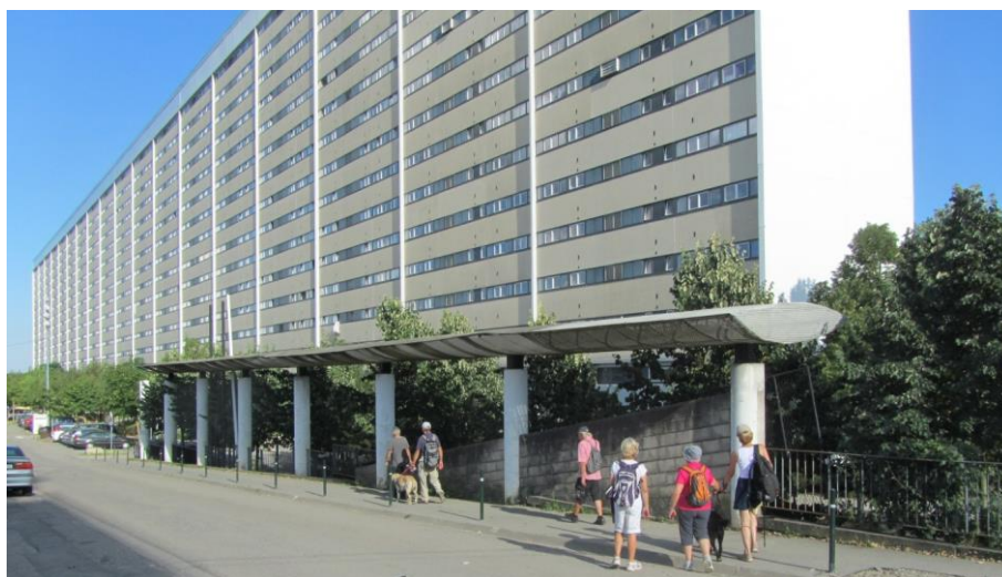
Photographie 61 : Ouvrage réalisé dans le cadre de la réhabilitation d'A. Sarfati (J.-M. Simon, Juillet 2015)
