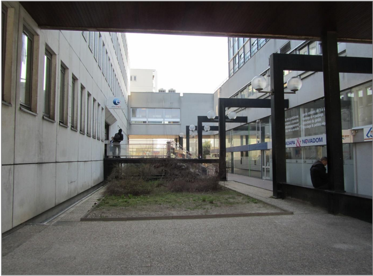
Photographie 43 : La coursive est de la galette (cliché J.-M. Simon, mai 2017).
