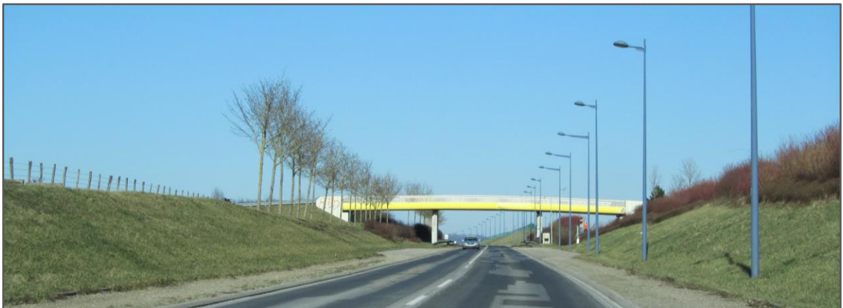
Photographie 84 : L'ouvrage d'art entre la rue d'Essey et le Pré Voirus de Saulxures-lès-Nancy (J.-M. Simon, février 2018)
