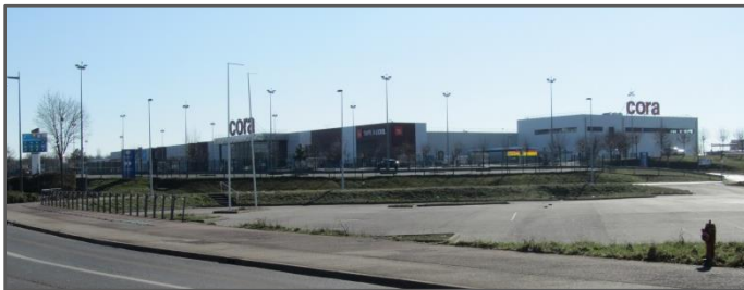
Photographie 86 : L'un des premiers bâtiments du site, le « Cora » (J.-M. Simon, février 2018).
