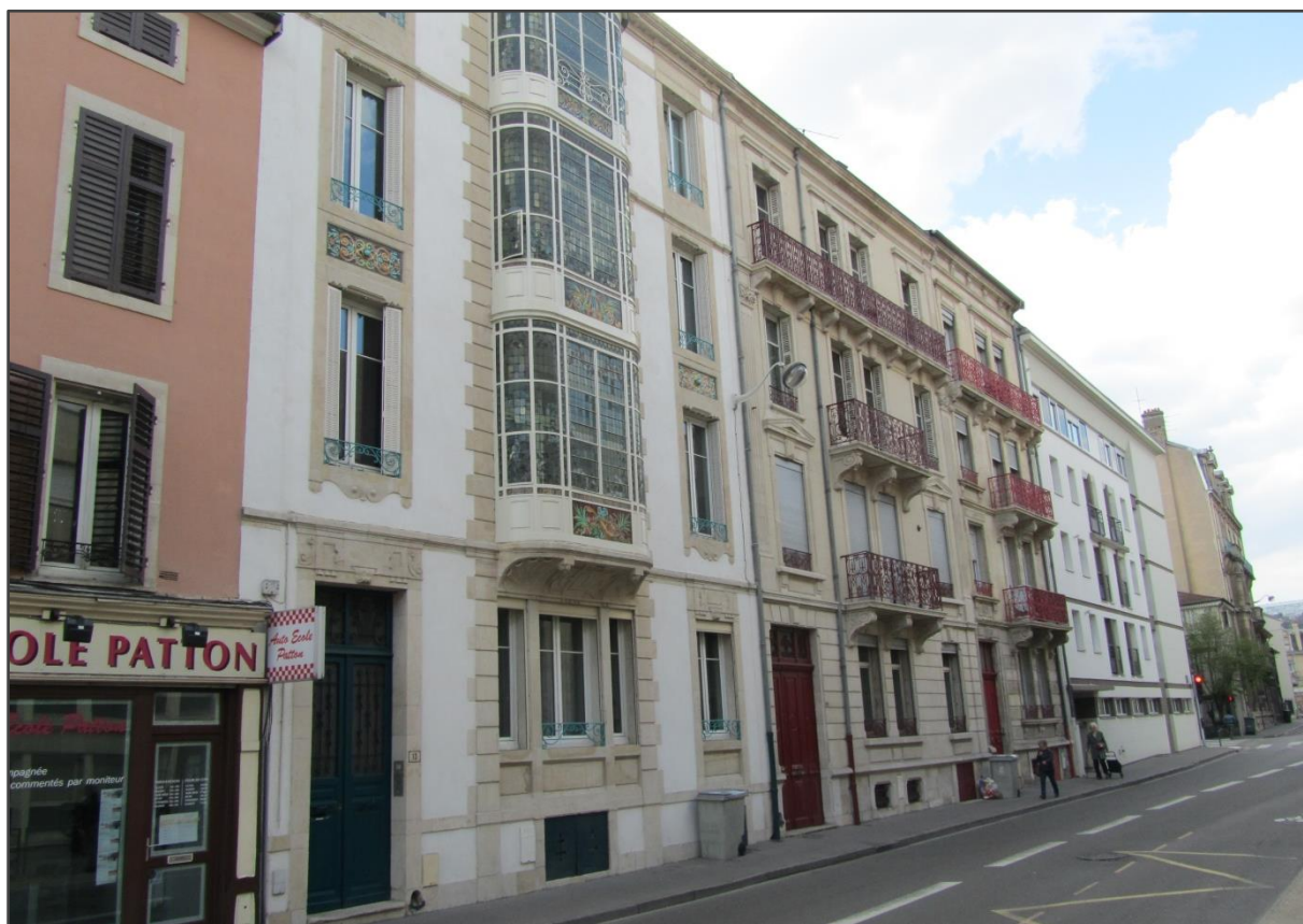
Photographie 49 : Les immeubles de la rue Patton (J.-M. Simon, septembre 2017)
