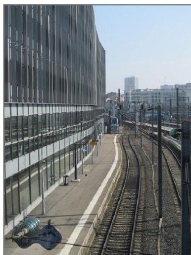
Photographie 38 : Le bâtiment de la république, côté voie ferrée (J.-M. Simon septembre 2017)
