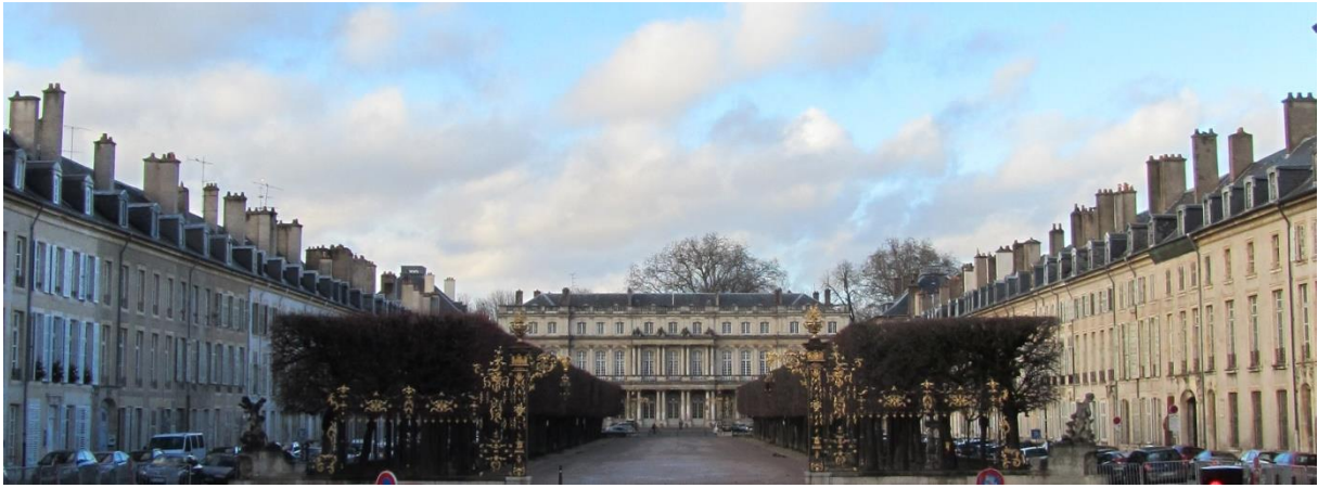
Photographie 33: La place de la Carrière, au fond le palais du gouverneur (J.-M. Simon, novembre 2017)
