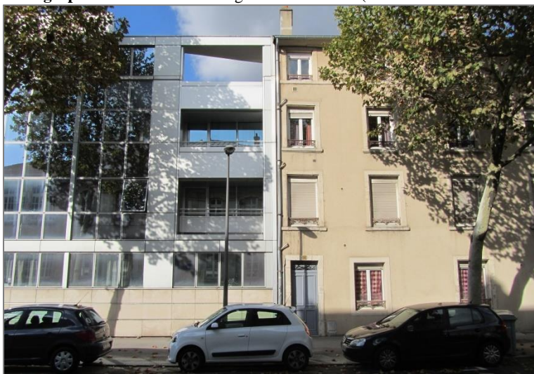
Photographie 25 : Immeuble de logements étudiants (J.-M. Simon octobre 2017)
