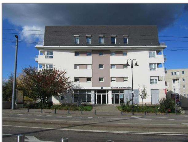
Photographie 12 : L'immeuble face au château 245 (J.-M. Simon, avril 2017)
