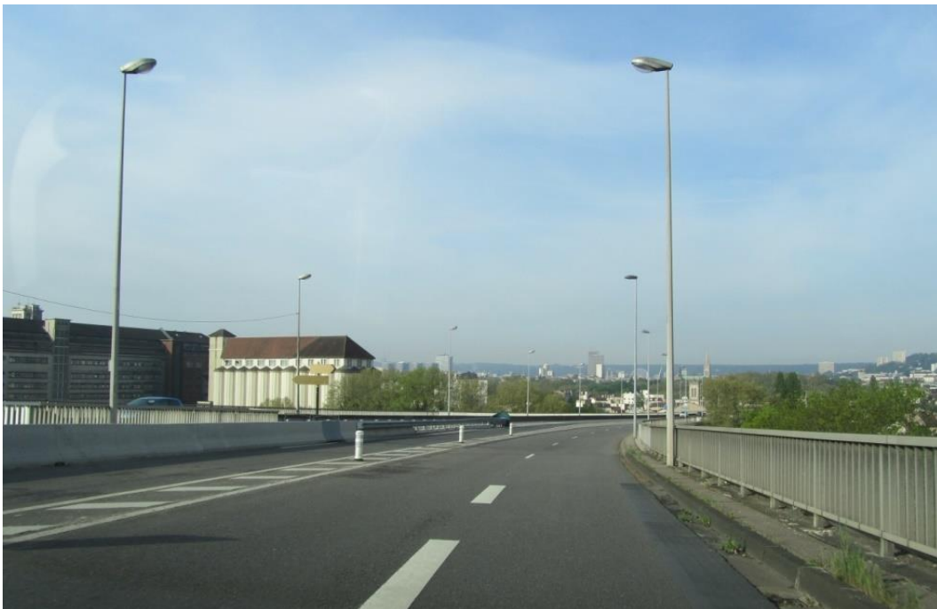
Photographie 1: Le viaduc Louis Marin, infrastructure construite en milieu urbain pour entrer dans Nancy. Le caractère est routier, mais la vitesse maximale autorisée est de 50 km/h (J.-M. Simon, juin 2016)
