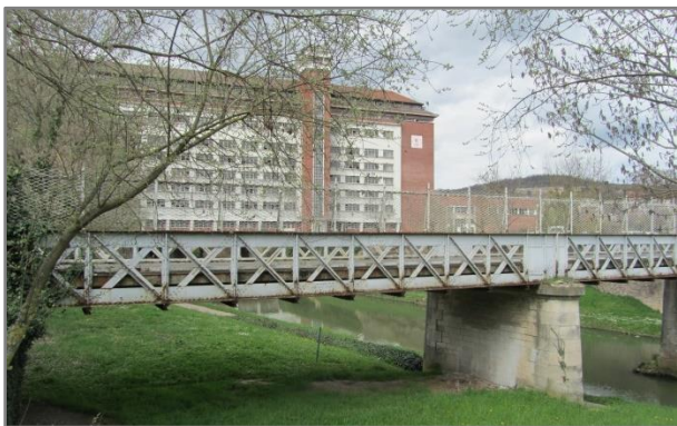
Photographie 19 : Les grands moulins dans l'axe du bras mort. (J.-M. Simon, novembre 2017).
