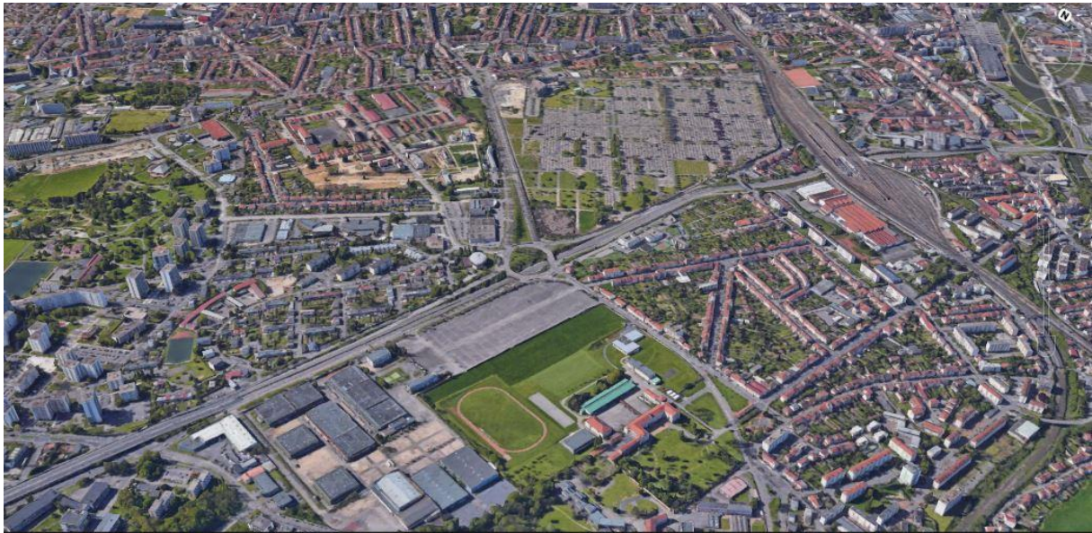
Photographie 77 : Vue oblique sur le carrefour Barthou (Google Earth, mai 2018)
