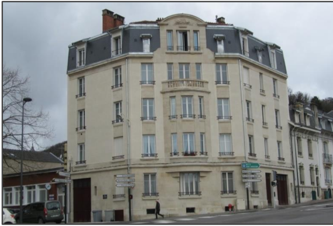
Photographie 52 : Un immeuble d'angle 1930, au début du boulevard de Scarpone (J.-M. Simon, janvier 2018).
