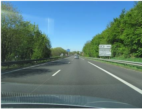
Photographie 69 : Abords de l'autoroute en partie courante (cliché J.-M. Simon, juin 2017)
