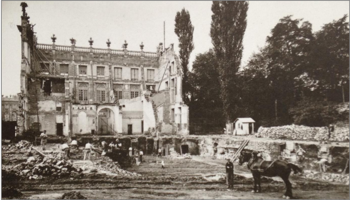
Document 37 : Les travaux de construction du Grand Théâtre : la façade conservée.1906. (AMAL, 1989, p. 32)
