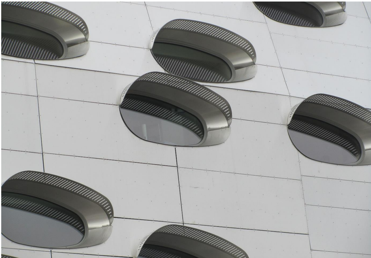
Photographie 29 : Le bâtiment Quai Ouest d'A. Démians (J.-M. Simon, mai 2017)
