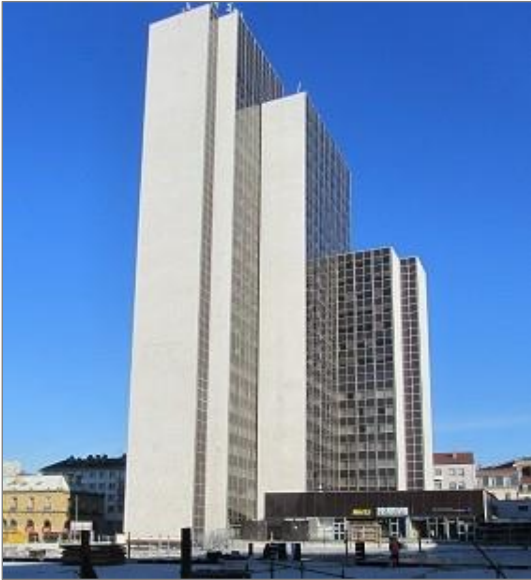
Photographie 37 : La Tour Thiers vue de la place (J.-M. Simon, mars 2015)
