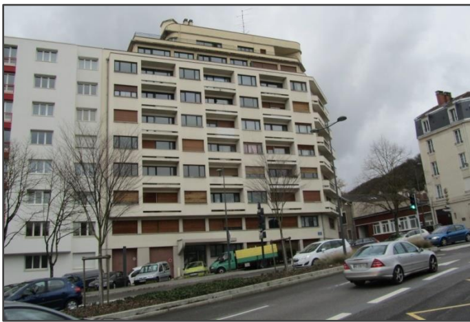
Photographie 53 : Immeuble des années 1960, situé en face de l'immeuble précédent (J.-M. Simon, janvier 2018)
