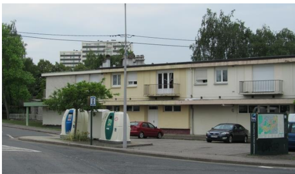
Photographie 79 : les vitrines de la partie basse sont rebouchées (J.-M. Simon, mai 2015)
