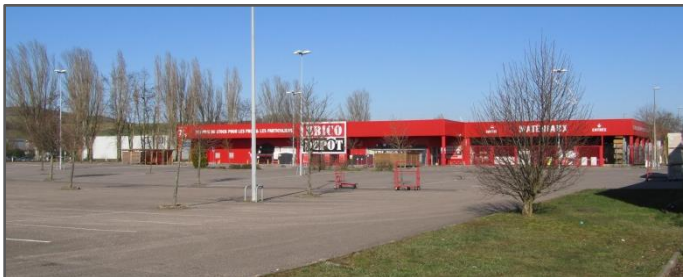
Photographie 87 : Un des premiers bâtiments de bricolage, le « Brico-dépôt », autrefois Castorama (J.-M. Simon, février 2018)
