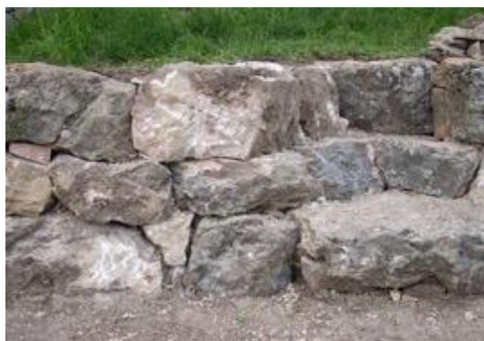
Mur de pierres sèches
