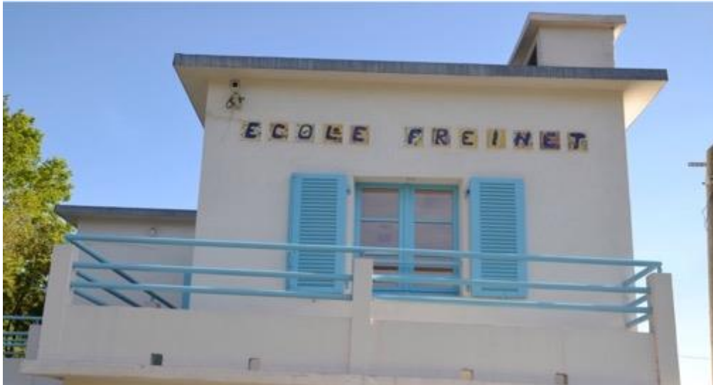
Entrée de l'École Freinet (ancien bâtiment de la CEL, actuel restaurant scolaire)
