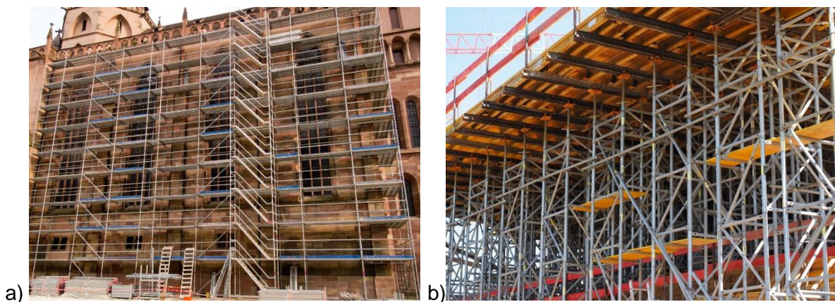
Fig. I.1. Équipements temporaires de chantier : a) Échafaudage de service ; b) Structure d'étalement
