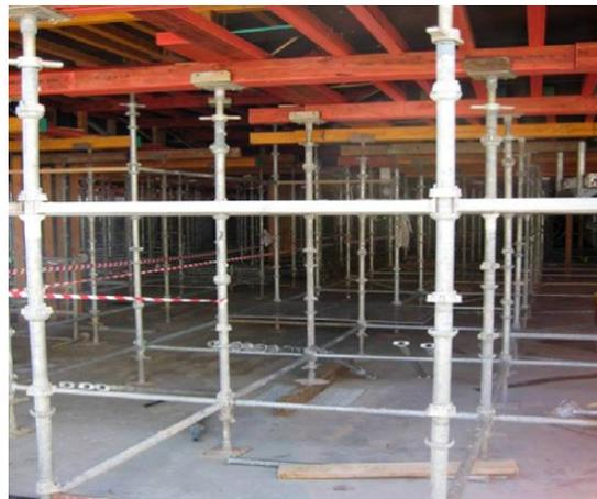
Fig. IV.12. Système d'échafaudage Cuplok.
