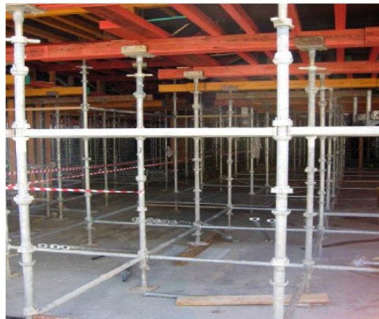
Fig. IV.12. Système d'échafaudage Cuplok.
