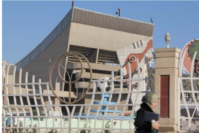
Figure 78 : Vue des alentours du Gymnase occupés depuis 2011 par des constructions dépareillées : le mausolée d'Amo Baba. 173
