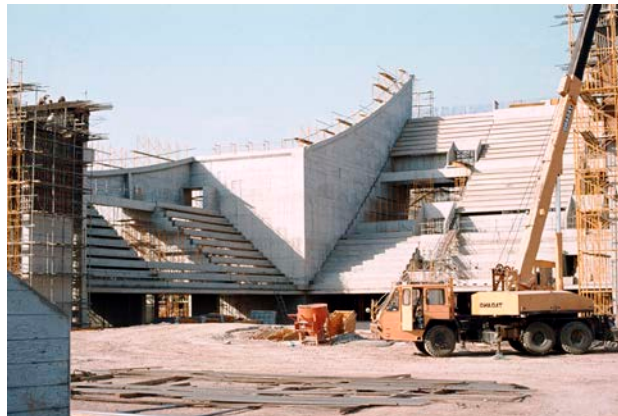
Figure 77 : Phases de la construction : l'intérieur. 172
