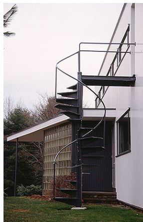
Figure 54: Maison de Walter Gropius. 162
