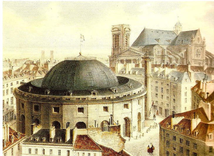
Figure 13: La cour de la Halle au Blé. 48
