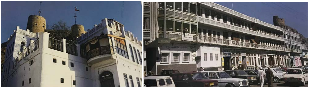
Figure 195 : (I. B), Le bâtiment Talib
