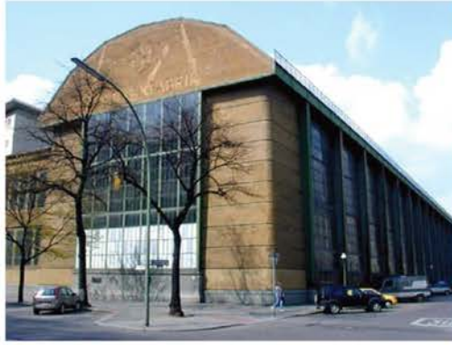
Figure 57 : AEG Turbine Factory, 1908–1909. Un des premiers exemples du classicisme industriel.
