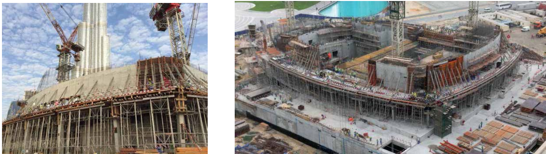
Figure 180: (I. B), Le chantier de l'Opéra l'opéra de Dubaï.
