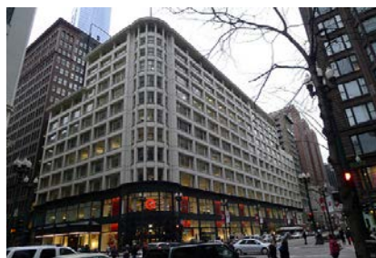
Figure 29: Le Carson, le grand magasin de Pirie Scott. 122
