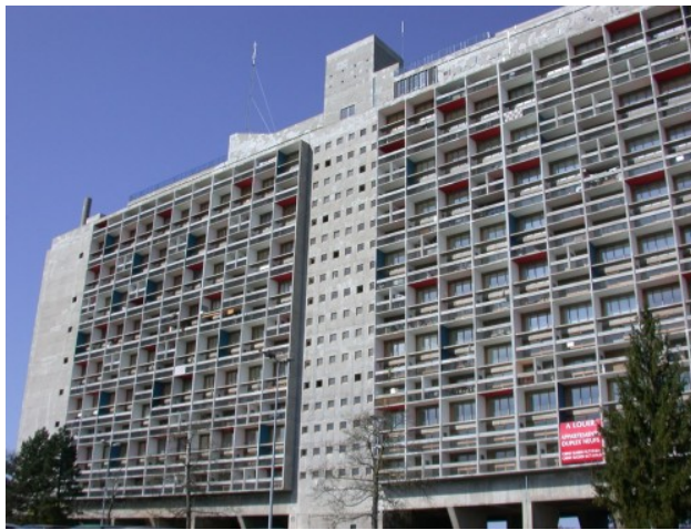
Figure 67 : L'Unité d'Habitation Firminy : Le Corbusier.
