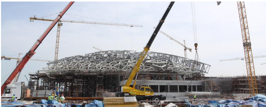
Figure 143: (I. B), Le dôme, en cours de construction.
