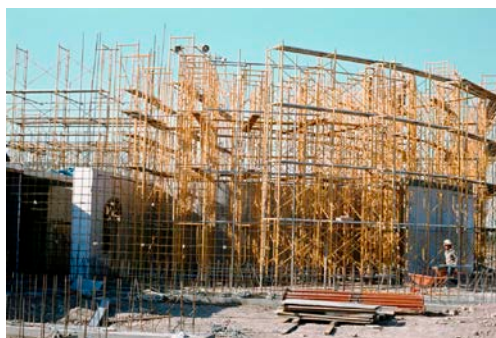
Figure 74 : Phases de la construction : la rampe. 169
