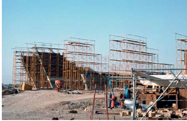
Figure 75 : Phases de la construction : la rampe. 170
