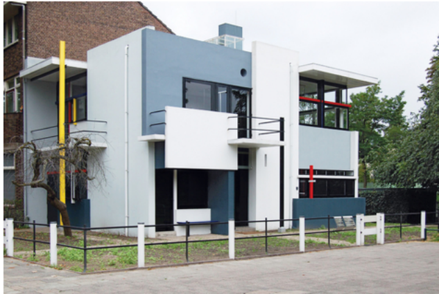
Figure 19: (I. B), Maison réalisée par Reetveld (1958–9) Utrecht, Hollande.
