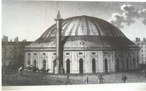
Figure 14: La cour de la Halle au Blé. 49
