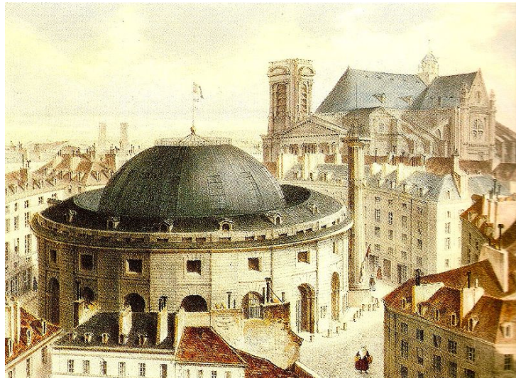
Figure 13: La cour de la Halle au Blé. 48
