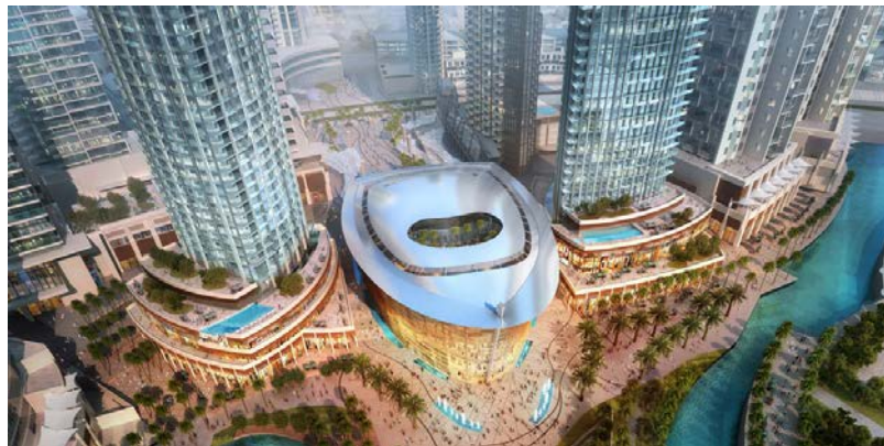
Figure 173: l'Opéra de Dubaï vue aérienne. 323
