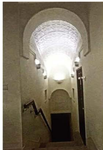
Figure 198 : (I. B), Cage d'escalier du premier étage montre le ceiling décoré de motifs géométriques sculptés dans du gypse.
