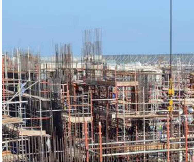
Figure 147: (I. B), Le chantier du musée du Louvre à Abu Dhabi, en cours de construction.
