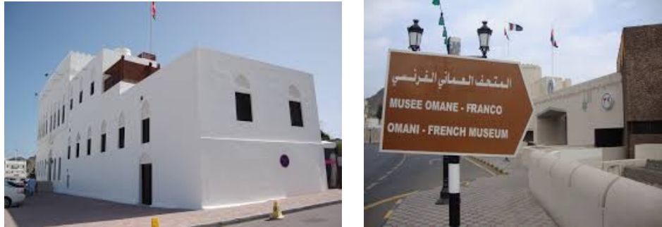
Figure 199 et Figure 200 : (I. B), le bâtiment de l'extérieur.
