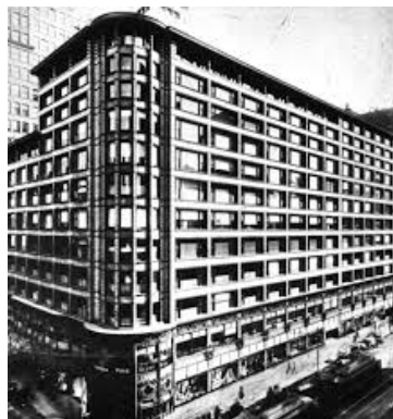
Figure 28: Le Carson, le grand magasin de Pirie Scott. 121
