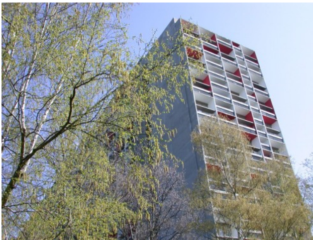
Figure 68 : L'Unité d'Habitation Firminy : Le Corbusier.
