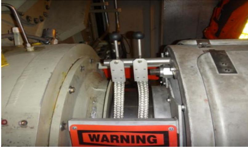
FIGURE 1.3.10 – Exemple de mesures de tension de palier : balais de type tresse utilisé pour le monitoring de la tension de palier, [Stone et al. \(2014\)](#)
