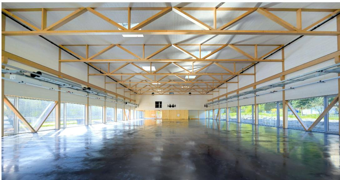
Figure 5-13 : Exemple de poutre treillis réalisée en LVL de hêtre (POLLMEIER).
