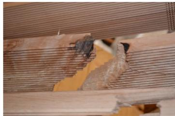
*Rupture de la poutre treillis au niveau d'un nœud.*
