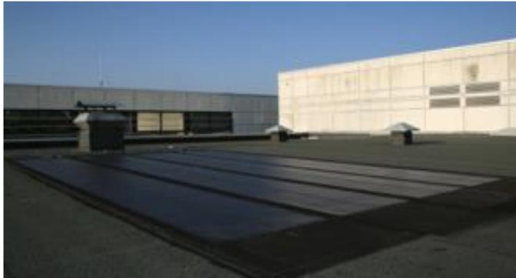
**Figure 22.** Réseau de modules PV de silicium amorphe 1kWc.
