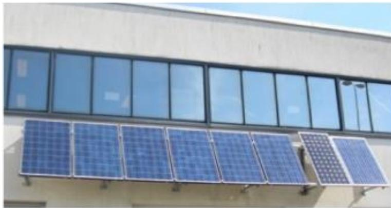
**Figure 21.** Réseau de 6 modules PV polycristallins de 1.2kWc.
