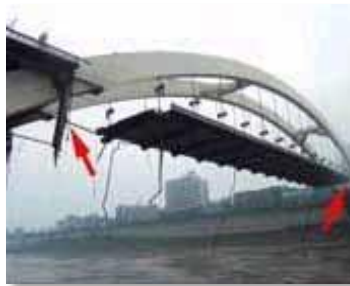
(d) Xiaonanmen Bridge
