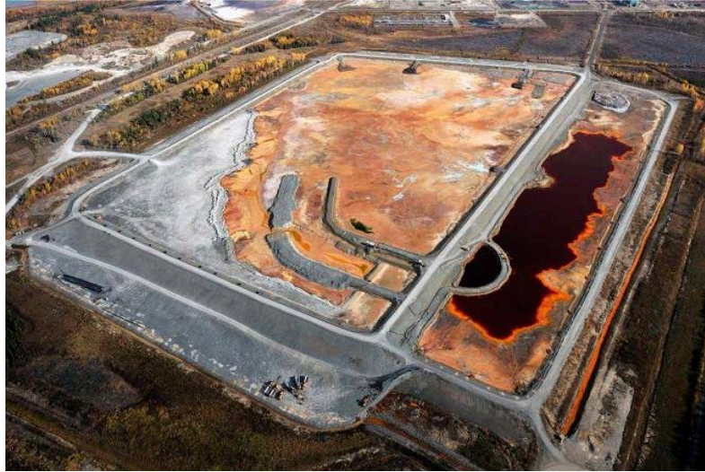
Figure 3-2 : Bassin de stockage de jarosite à Timmins, Ontario [117]
