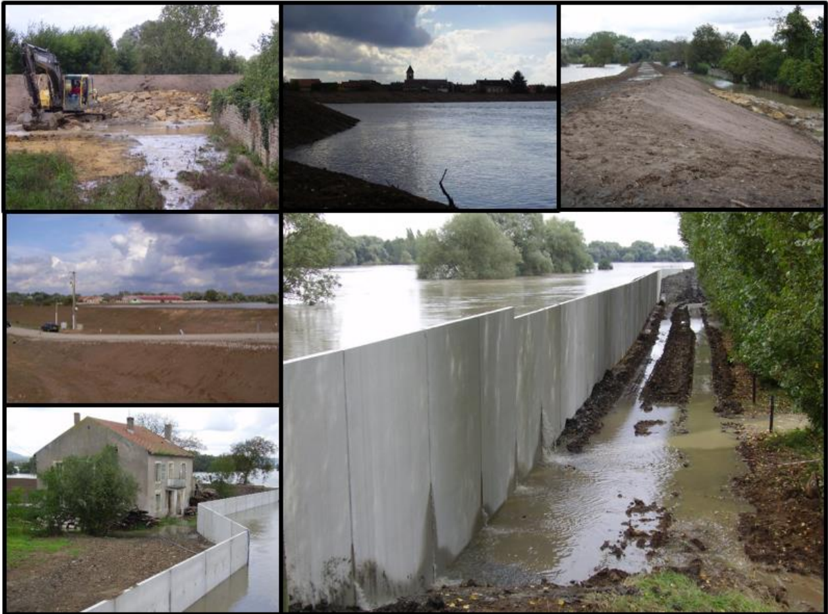
PHOTO 5 - FINALISATION DES DIGUES EN URGENCE ET INSTALLATION DE PALPLANCHES TEMPORAIRES, CRUE DU 05/11/2006 (MOSELLE) À HAUCONCOURT (E. GILLE 2006)
