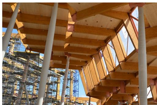
Fig. 1.3 Les boomerangs bois en tiges collées de la structure de l'Aqualagon (© arbonis, [www.arbonis.com](http://www.arbonis.com)).
