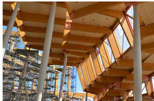
Fig. 1.3 Les boomerangs bois en tiges collées de la structure de l'Aqualagon (© arbonis, www.arbonis.com ).
