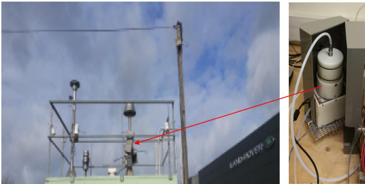
Figure II- 13 Dispositif micro-capteurs de gaz placé à l'extérieur sur le toit de la station d'ATMO Grand Est.
