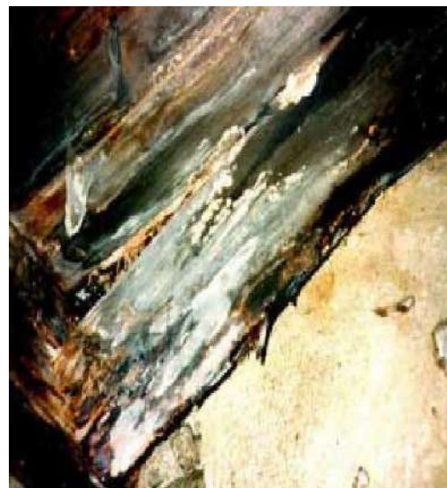
Figure 23: Attaque du bois par les échauffures.
