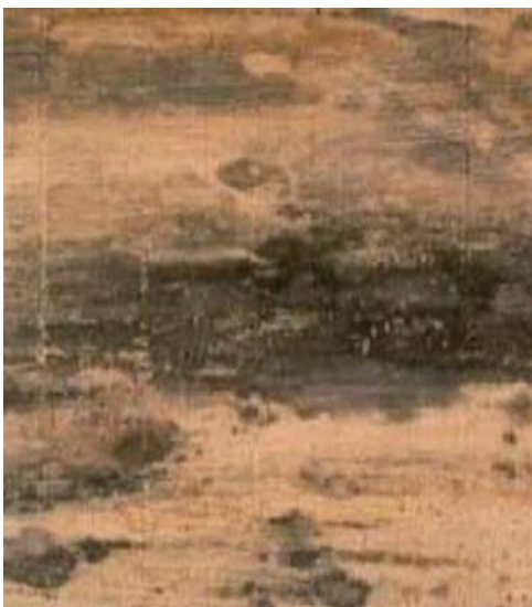
Figure 24: Bleuissement primaire sur du bois fraîchement scié.
