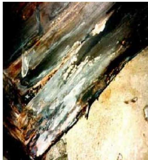
**Figure 23:** Attaque du bois par les échauffures.
