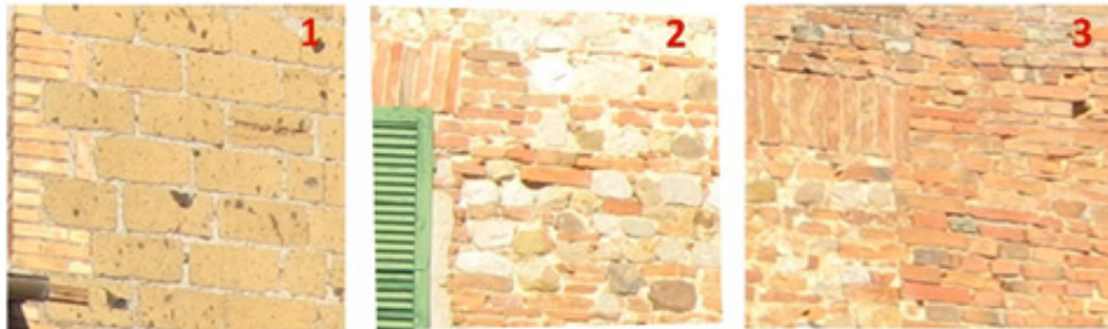
Figure 1 : Modification de l'appareil en hauteur. Photographie 2012 (
