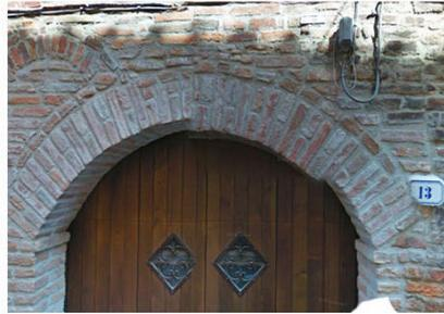
L'ancien arc toujours visible sur la façade à gauche et la qualité des briques de l'arc d'entrée permettent de comprendre qu'il s'agit d'un remaniement de la baie. Cependant, bien que relativement récent, le style a été maintenu et se fond parfaitement avec le décors.
