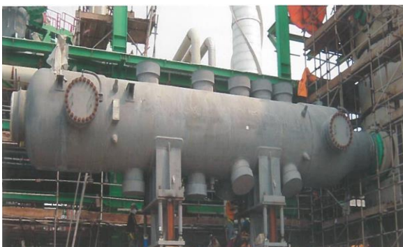
Figure I - 3. Exemple de WHB : installé sur site (à gauche) et arrangement spatial interne des tubes (à droite). (Brochure Process Gas Cooler Alstom).
