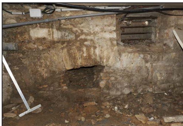
Figure 197 : vue de la voûte de l'aqueduc souterrain dans une cave au 5 rue d'Éton (cliché : J.-C. Sztuka)
