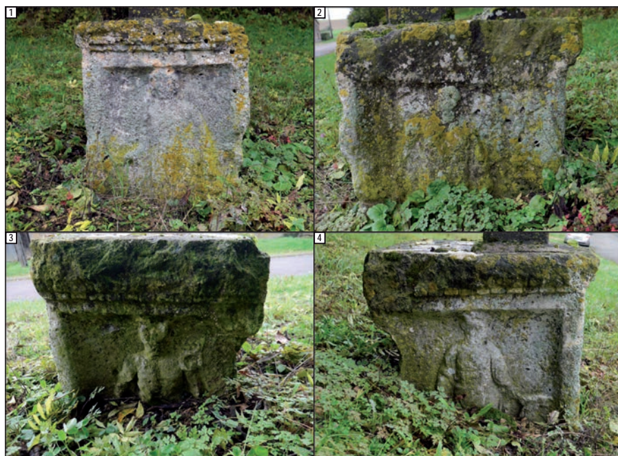
Figure 333 : vues de détail. 1 -face est, 2 -face nord, 3 -face ouest, 4 -face sud
