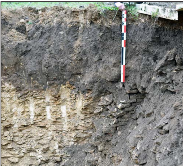
Figure 153 : cave découverte fortuitement lors de travaux au 3 rue de l'Étang en janvier 2019 (cliché : J.-C. Sztuka)
