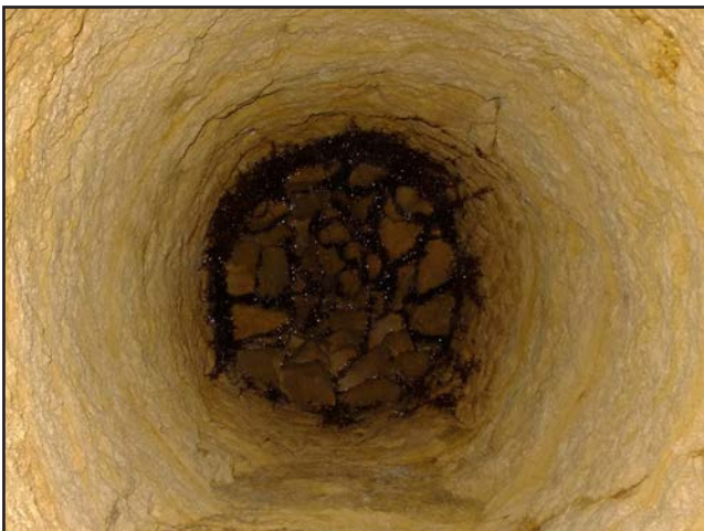
Figure 361 : puits d'accès de l'aqueduc oriental (cliché : B. Losson)
