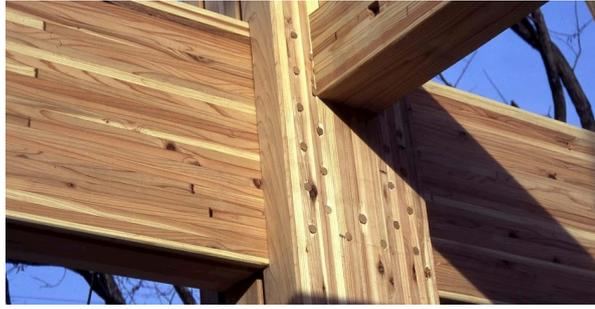
FIGURE 2.62 – Assemblage par tourillons en bois densifié.
