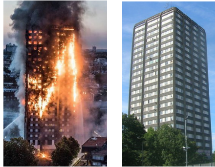
FIGURE 2.42 – Dégâts d’incendie de la tour Grenfell à Londres.
