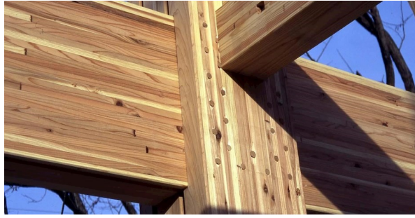
FIGURE 2.62 – Assemblage par tourillons en bois densifié.
