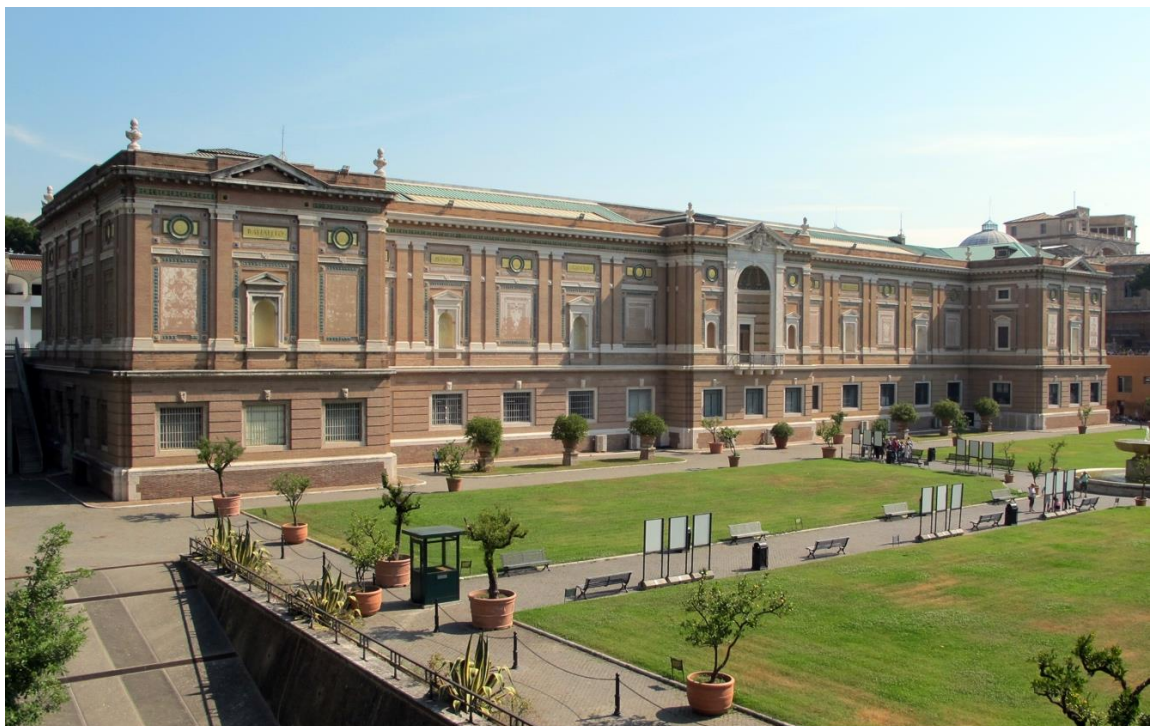
Fig. 57 – Pinacothèque du Vatican construite en 1932 par l'architecte Luca Beltrami (1854-1933), Cité du Vatican, s. d.
