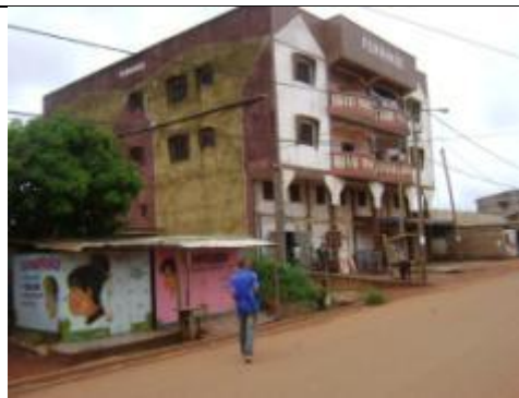
Immeuble R+2 au quartier Mendong
