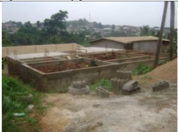
Immeuble en construction au quartier Ngoussou
