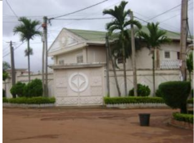
Immeuble bâti au quartier Nsiméyong, propriété d'un migrant résidant en Espagne
