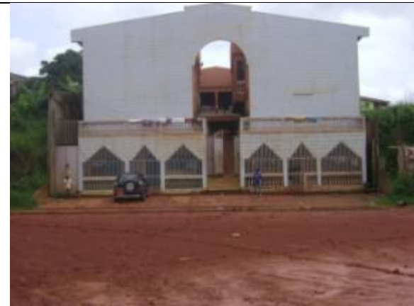
Immeuble à plusieurs appartements au quartier Mendong
