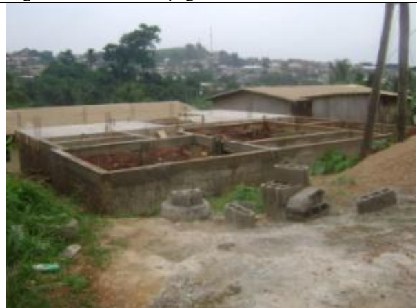
Immeuble en construction au quartier Ngousso
