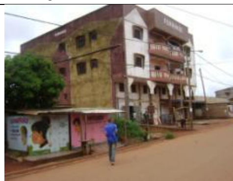
Immeuble R+2 au quartier Mendong
