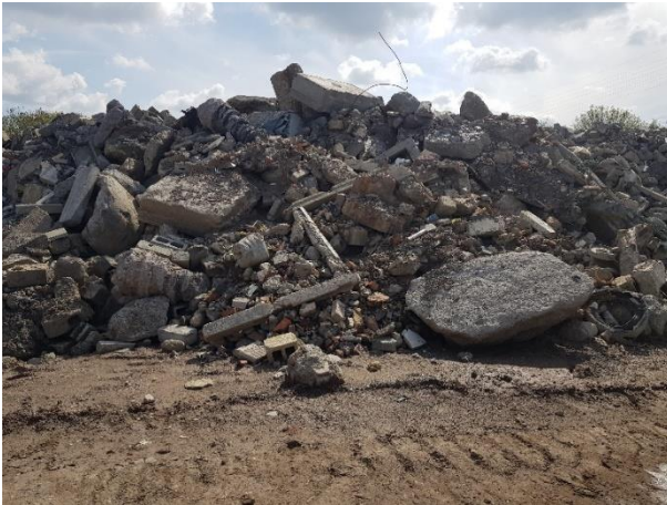
I) Déchets de démolition de bâtiments
