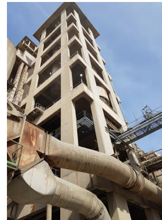
II) Tour de préchauffage en cyclones
