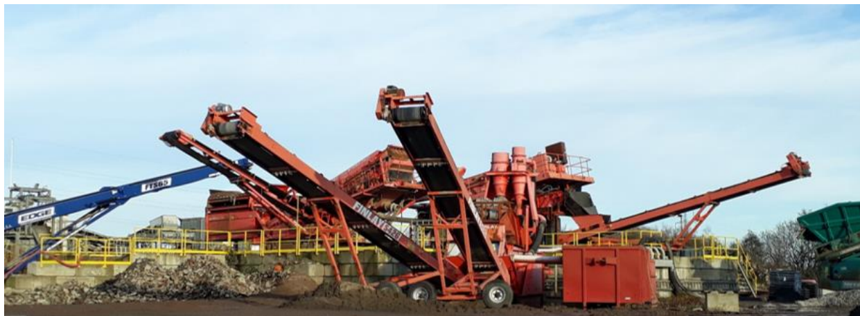
Figure 26. Installation de traitement de DCD par voie humide (Tradecowall®, partenaire du projet SeRaMCo)
