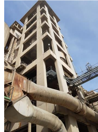
II) Tour de préchauffage en cyclones
