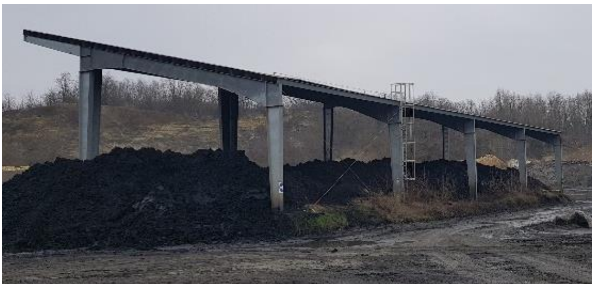
Figure 46. Plateforme de stockage des déchets industriels (sables de fonderie, etc.) utilisés par la cimenterie VICAT à Créchy (photographie personnelle)
