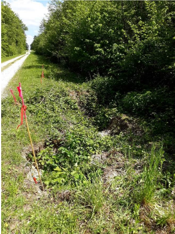
Photo 7.21 – Doline-gouffre embryonnaire (n° 2714) ouverte dans le fossé d'évacuation des eaux d'une route de débardage. Les travaux exploratoires (GERSM, 2019) ont préconisé la fermeture de la route aux camions de débardages afin d'éviter la destruction du chemin (Trois-Fontaines-l'Abbaye, secteur de la Taille Clergé) (cliché : Bensaadi 2019)
