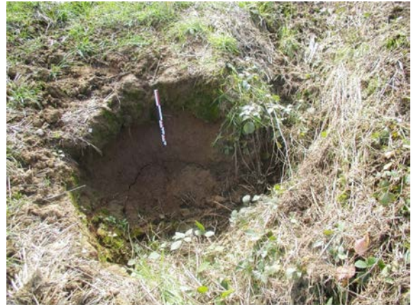
Photo 7.10 – Zoom de la doline d’effondrement observée à Ancerville en octobre 2019 (cliché : Goutorbe – GERSM, 2019)
