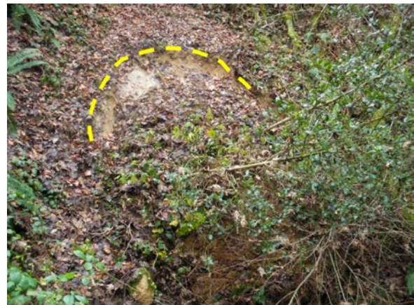
Photo 7.17 – Tête de glissement dans une doline active, secteur des Hattons (n° 2380) (cliché : Harmand, 2006)
