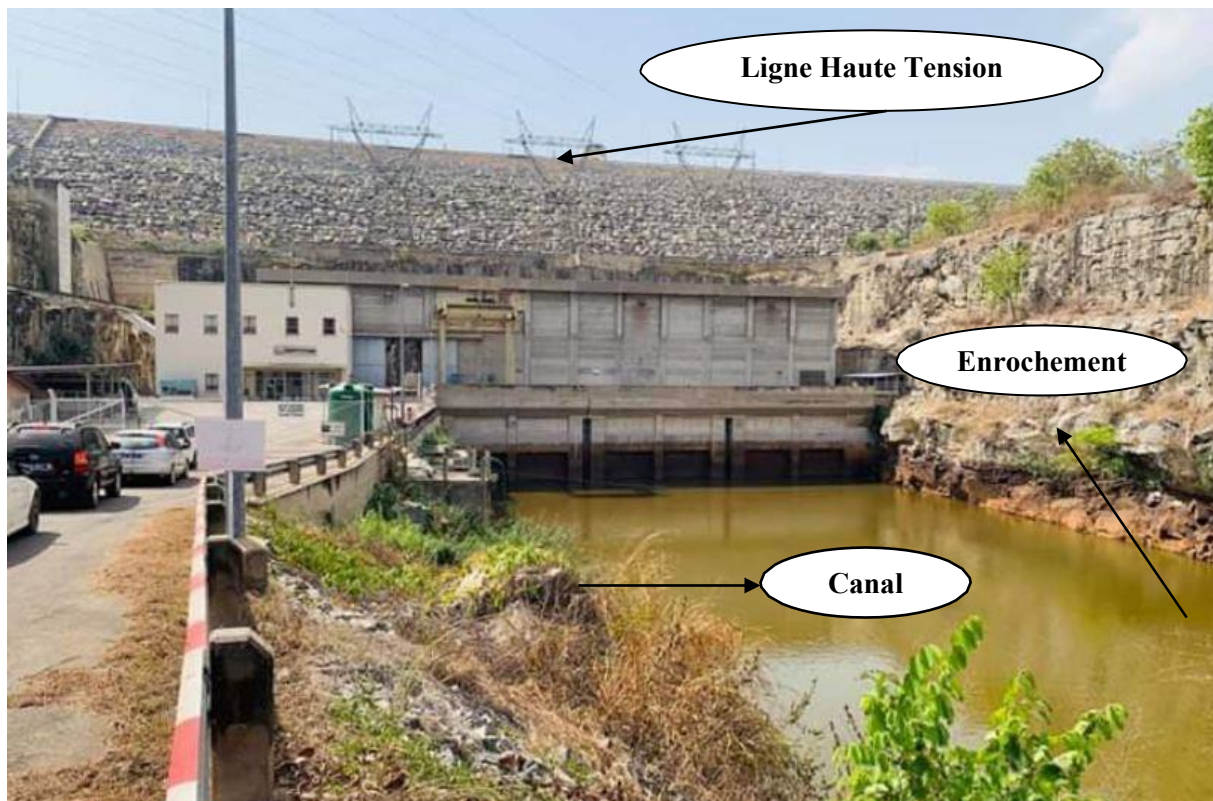
Photo 3 : Aménagement hydroélectrique de Taabo
