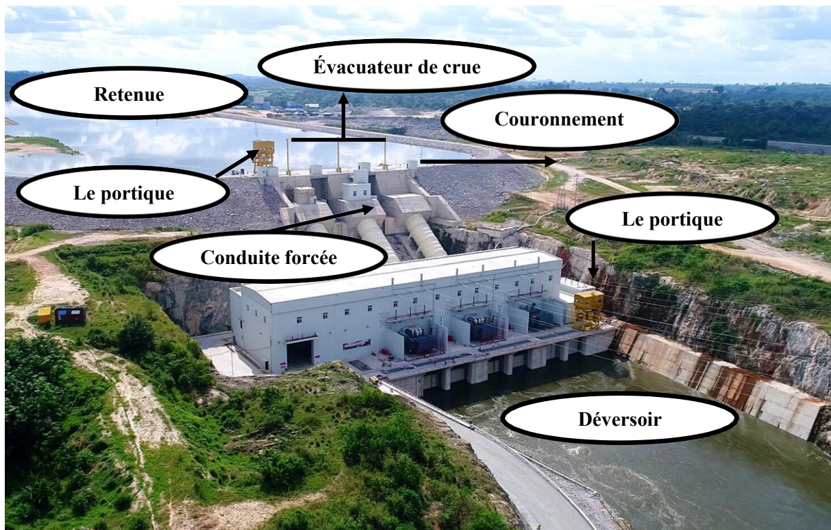
Photo 4 : Vue aérienne du barrage hydroélectrique de Soubré
