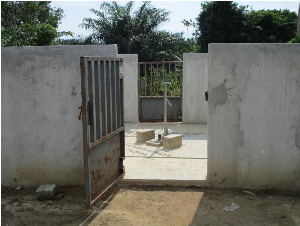
Photo 12 : Vue des infrastructures socio-collectives du village d'Eholié
