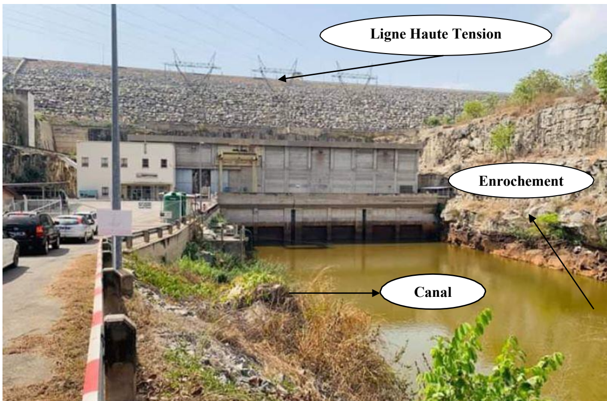
Photo 3 : Aménagement hydroélectrique de Taabo
