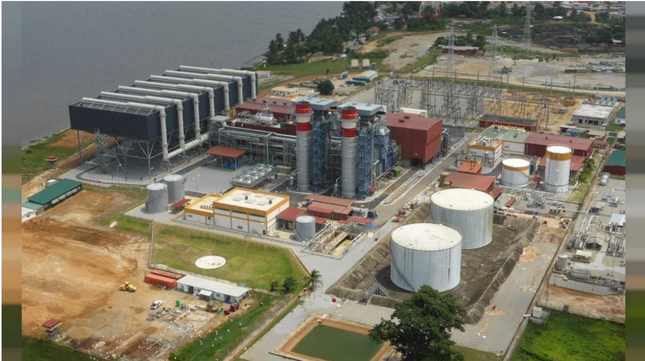
Photo 1 : La centrale d’Azito, dans la banlieue d’Abidjan, est la plus puissante centrale de production électrique du pays
