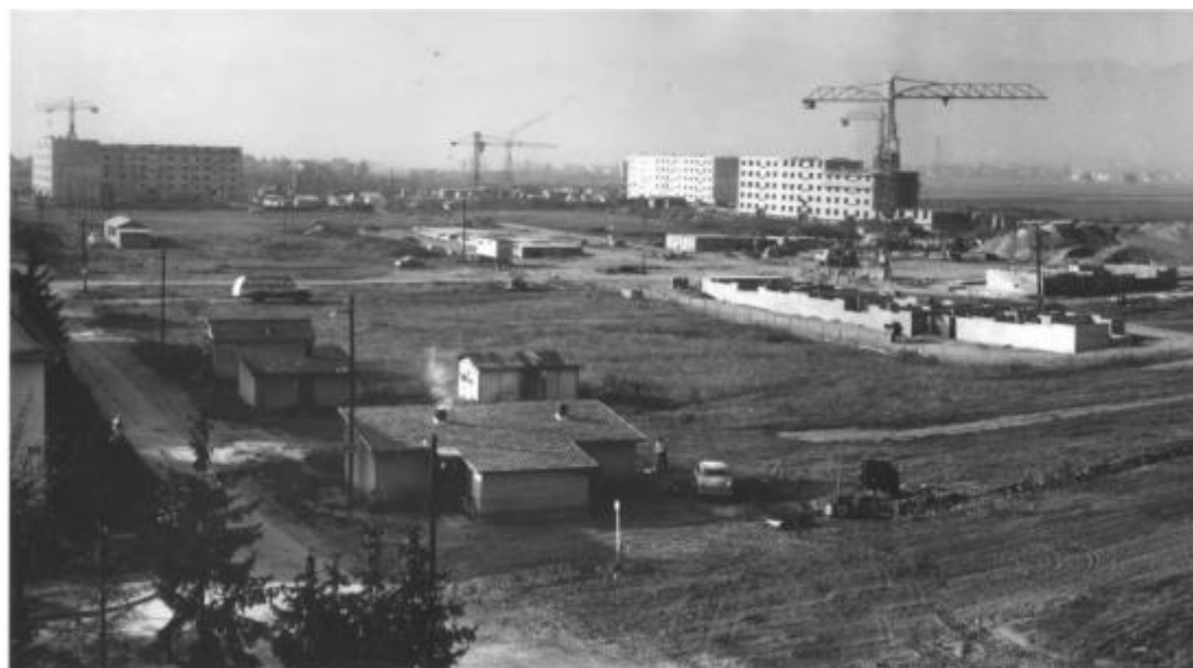
Construction des groupes 22 « Palais Royal » et 19 « Rapatriés »
