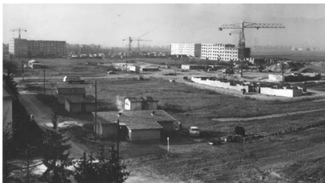
Construction des groupes 22 « Palais Royal » et 19 « Rapatriés »
